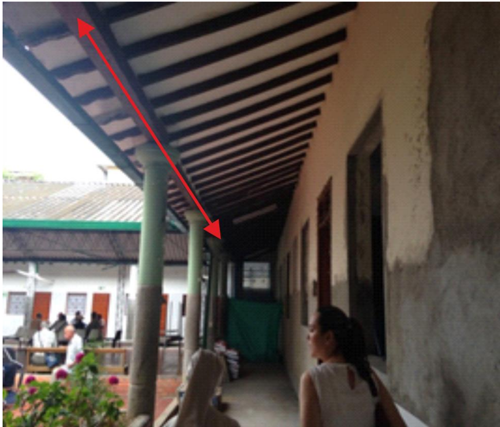
Figura 65. Vigas en madera
