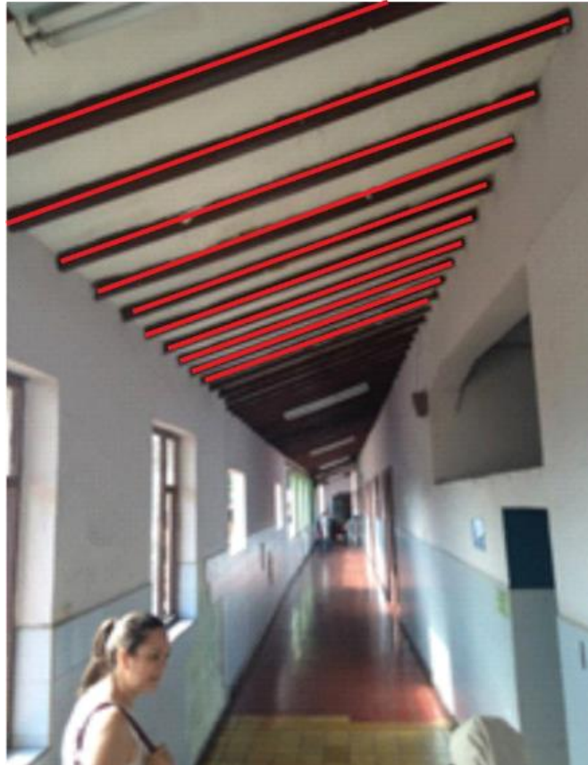
Figura 66. Soporte de la cubierta
