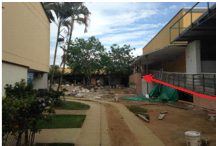
Figura 47. Construcción actual por ampliación del lugar
