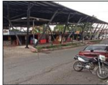
Fotografía 2 (Estado de la vía - Calle 10, Fuente: Autor).
