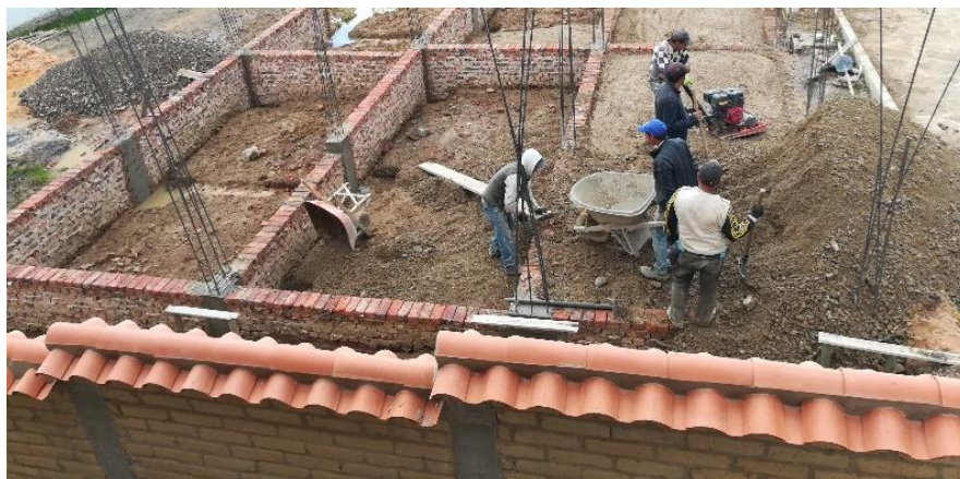
Figura 6. Extendida de recebo y compactación
