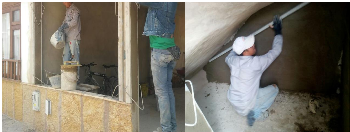
Figura 14.Utilización de reglas (boquilleras)
