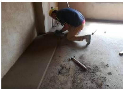
Figura 18. Realización de filos
