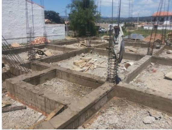
Figura 9. Vigas desencofradas
