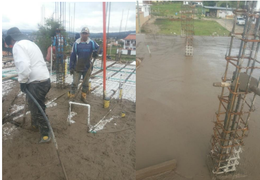
Figura 11. Fundida de losa
