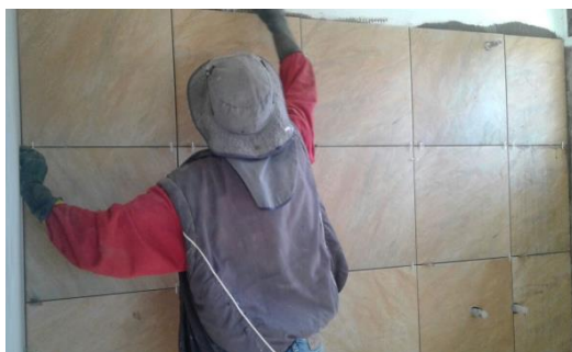
Figura 22. Enchape Muro
