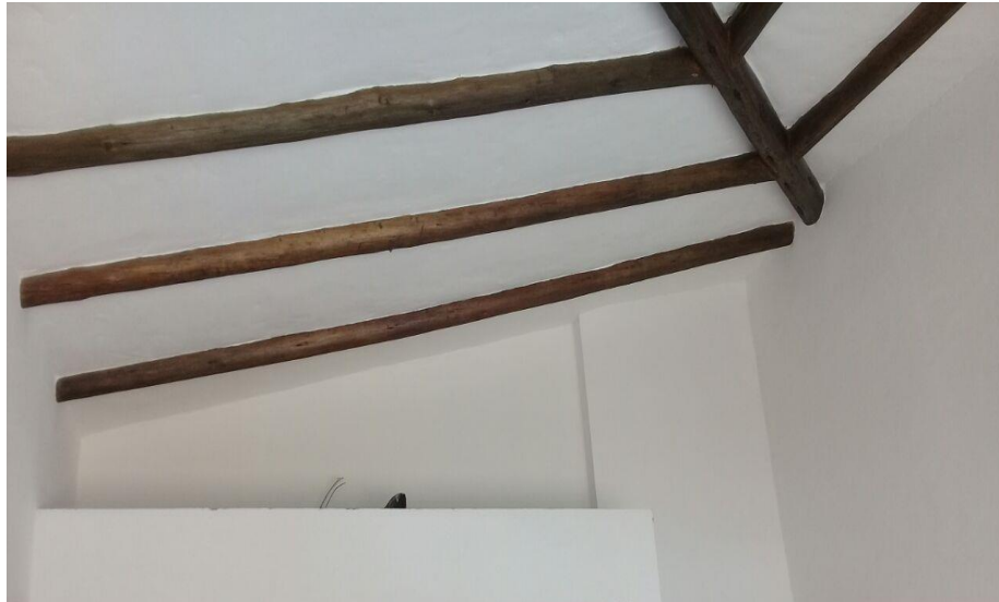
Figura 21. Acabado de techo ( segundo piso)
