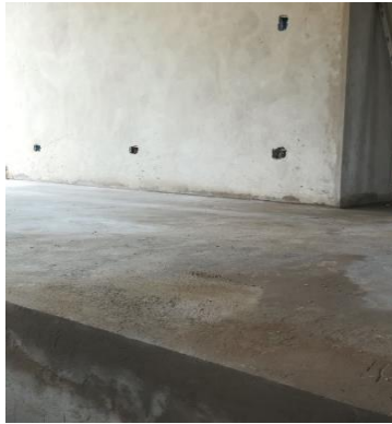
Figura 19. Nivelación de mortero terminado (segundo piso)
