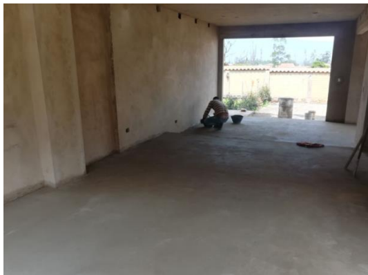
Figura 17.Afinado de piso en mortero
