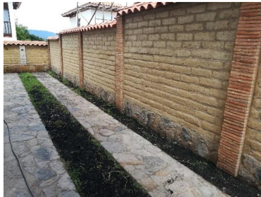
Figura 25.Muro en adobe terminado
