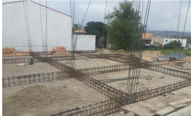
Figura 7. Armadura de vigas
