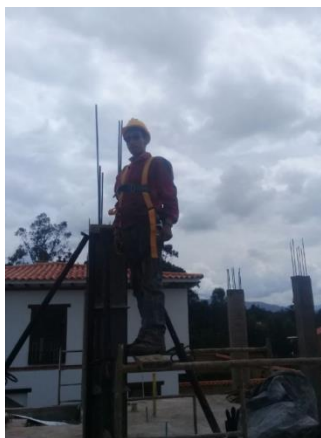
Figura 30. Obrero con EPP
