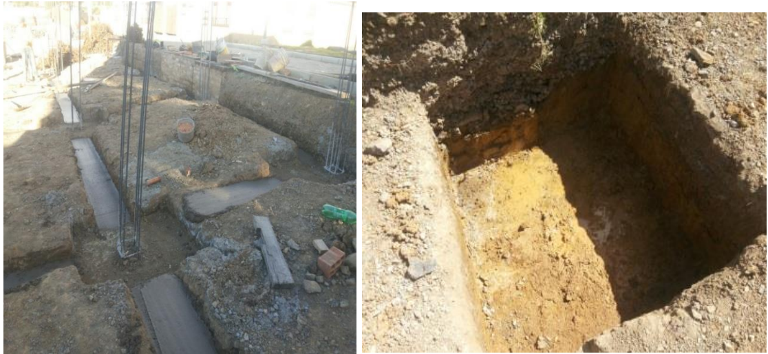
Figura 3. Zapatas y solados fundidos, excavación de zapatas
