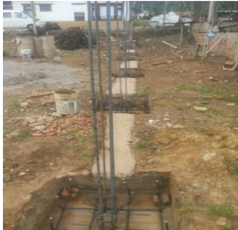
Figura 26.Cimentación muro divisorio
