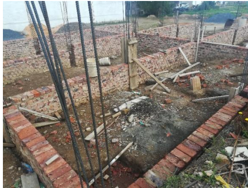
Figura 5. Inicio de encofrado
