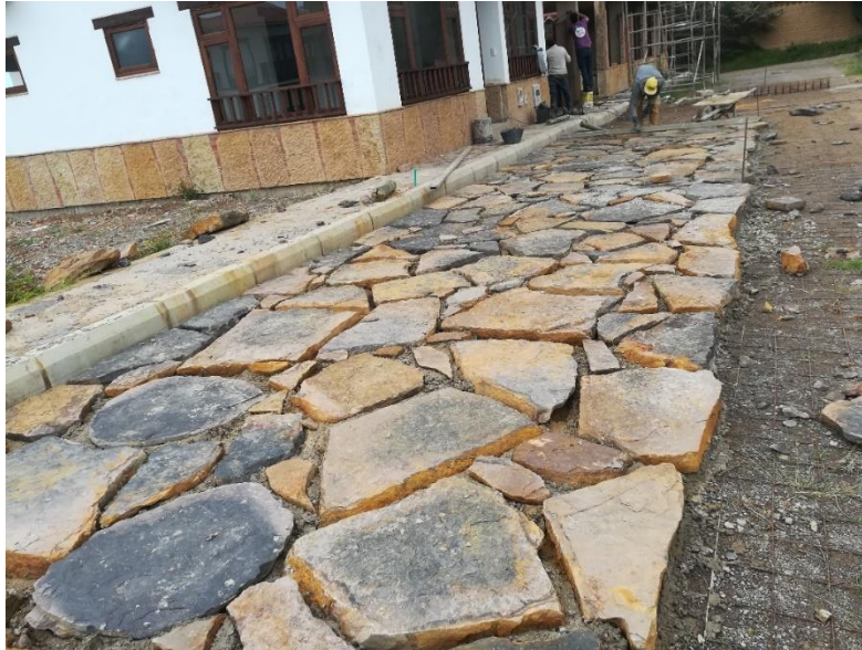
Figura 28. Instalación de adoquín de piedra laja
