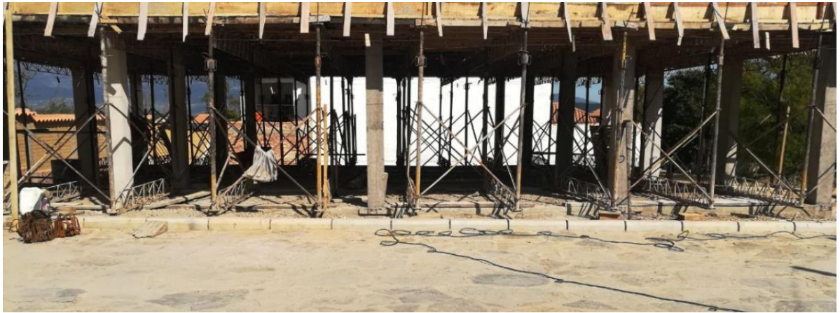
Figura 10. Columnas primer piso y armadura de placa
