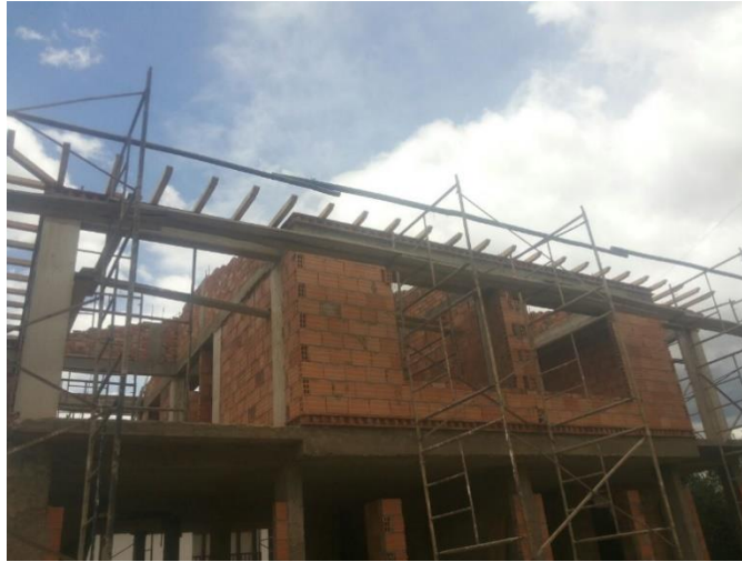
Figura 12. Canes instalados
