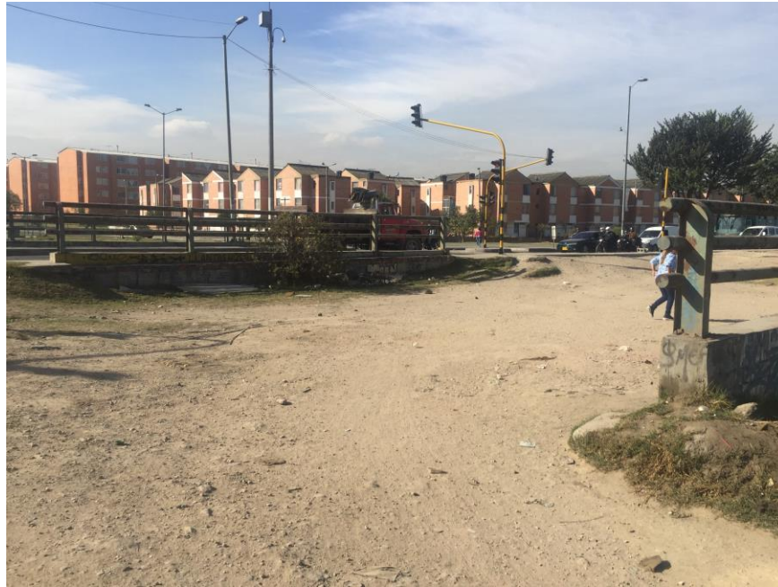
Fotografía 1. Panorámica del Box Coulvert.
