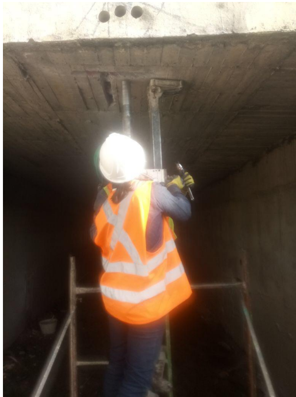
Ilustración 20. Extracción de núcleos en placa Fuente: Consorcio Sedic-Concol 023
