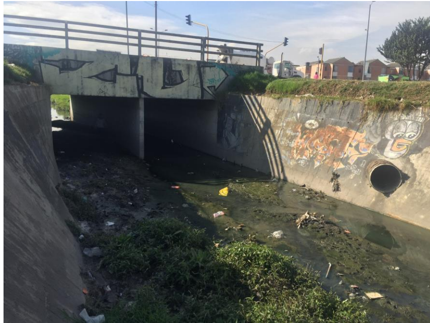
Fotografía 2. Vista Lateral Box Coulvert.
