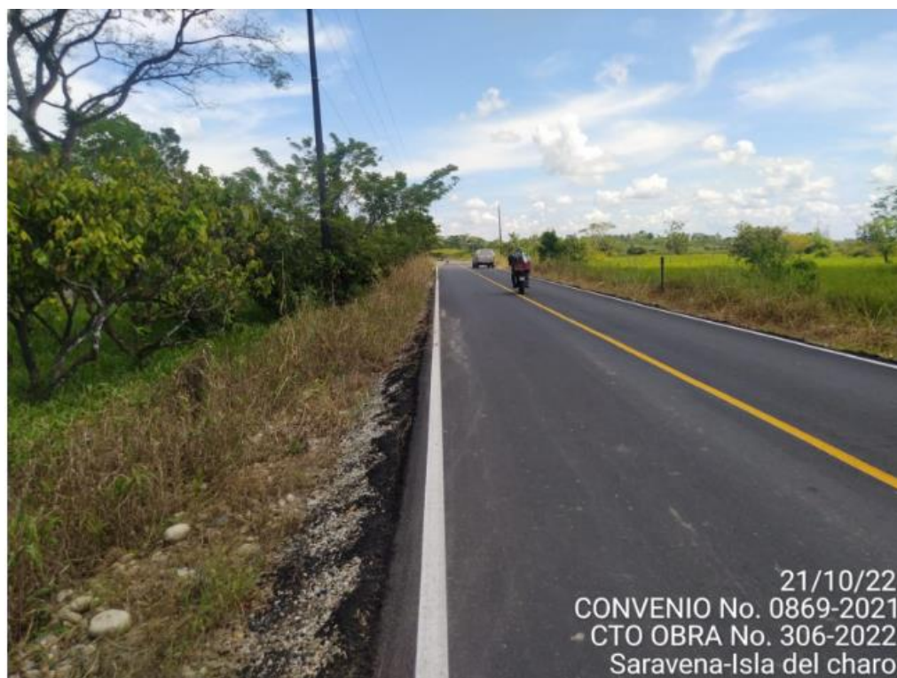
Figura 10. Corredor vial ejecutado, Vía Isla El Charo
