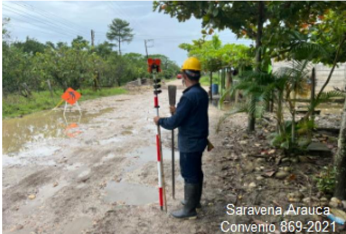
Figura 3. Estado inicial a intervenir, Saravena-Arauca
