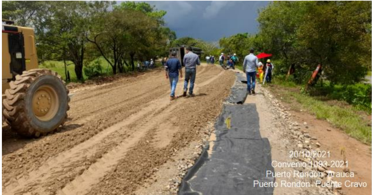
Figura 15: Corredor vial en ejecución, Puerto Rondón-Arauca
