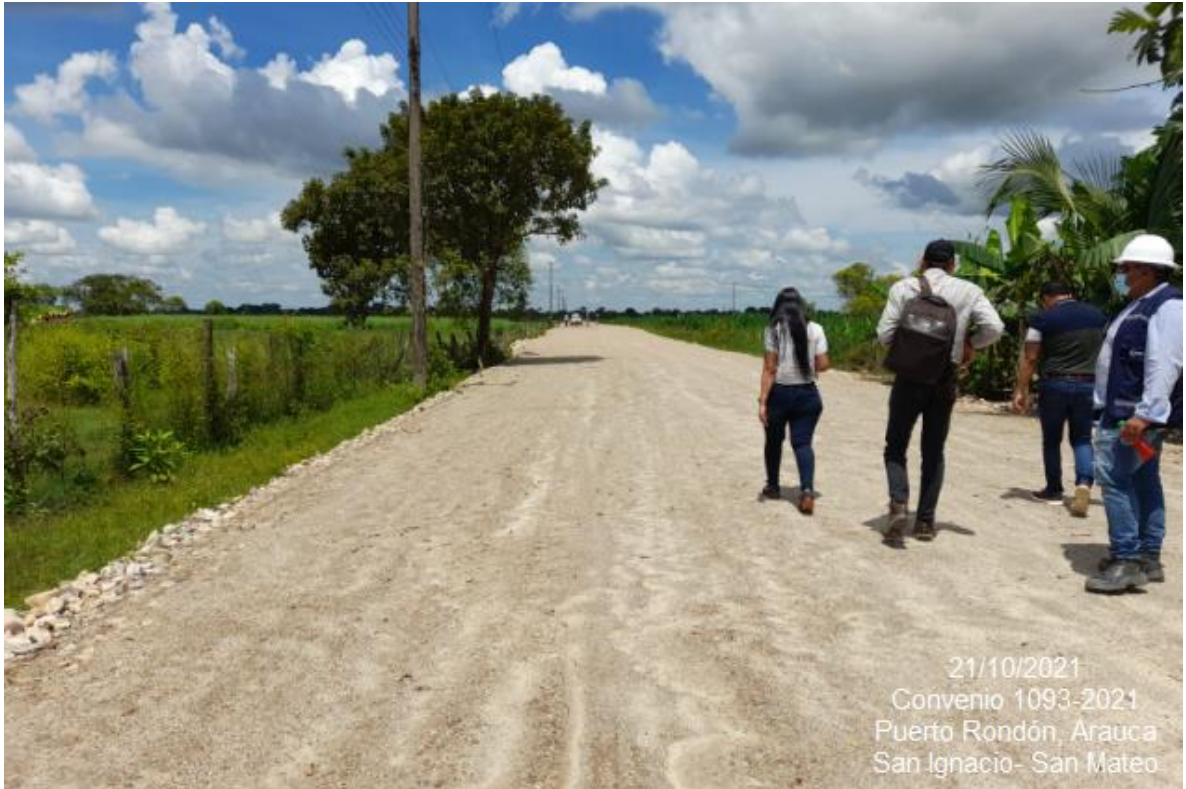
Figura 14: Corredor vial en ejecución, Puerto Rondón-Arauca
