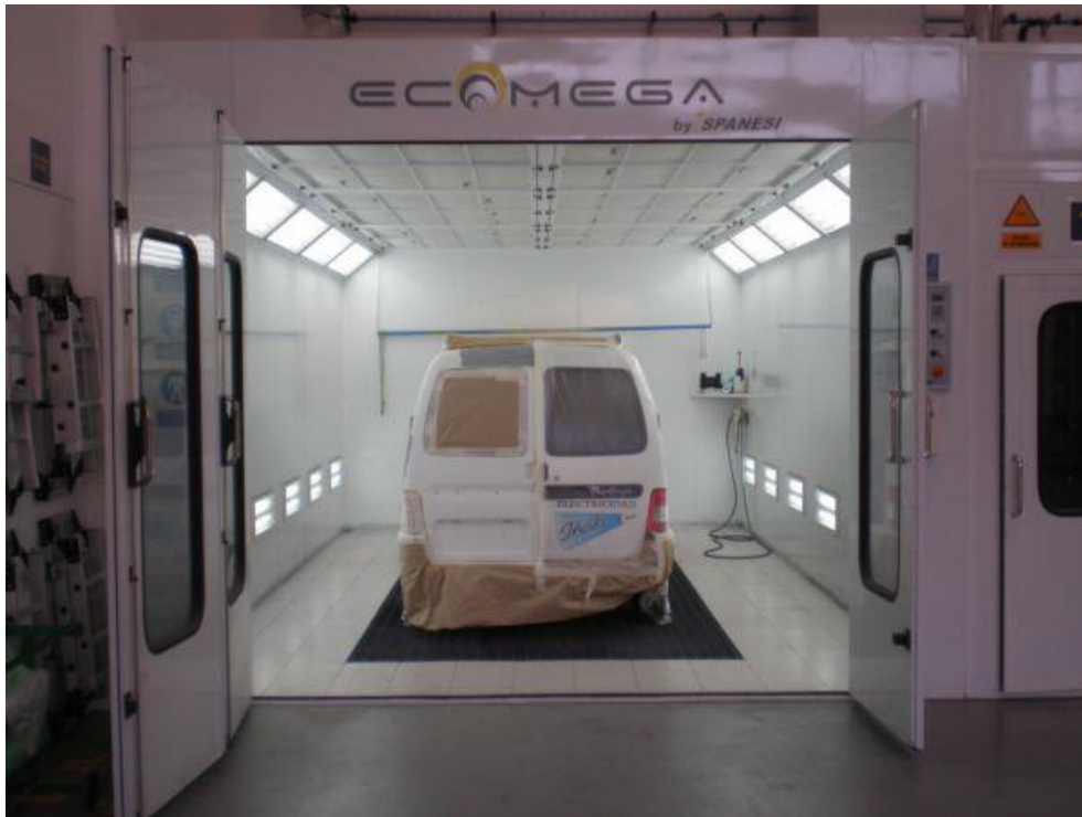
Figura 29. Cabina de pinturas
