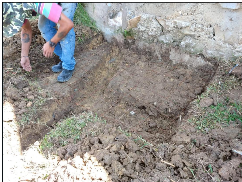
Figura 15. Excavación para puesta de lava botas y lavamanos contra el COVID.
