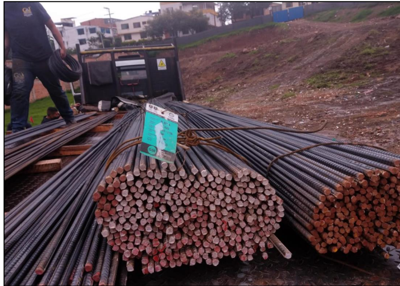
Figura 19. Recepción de varillas de acero para refuerzo de muros de contención.
