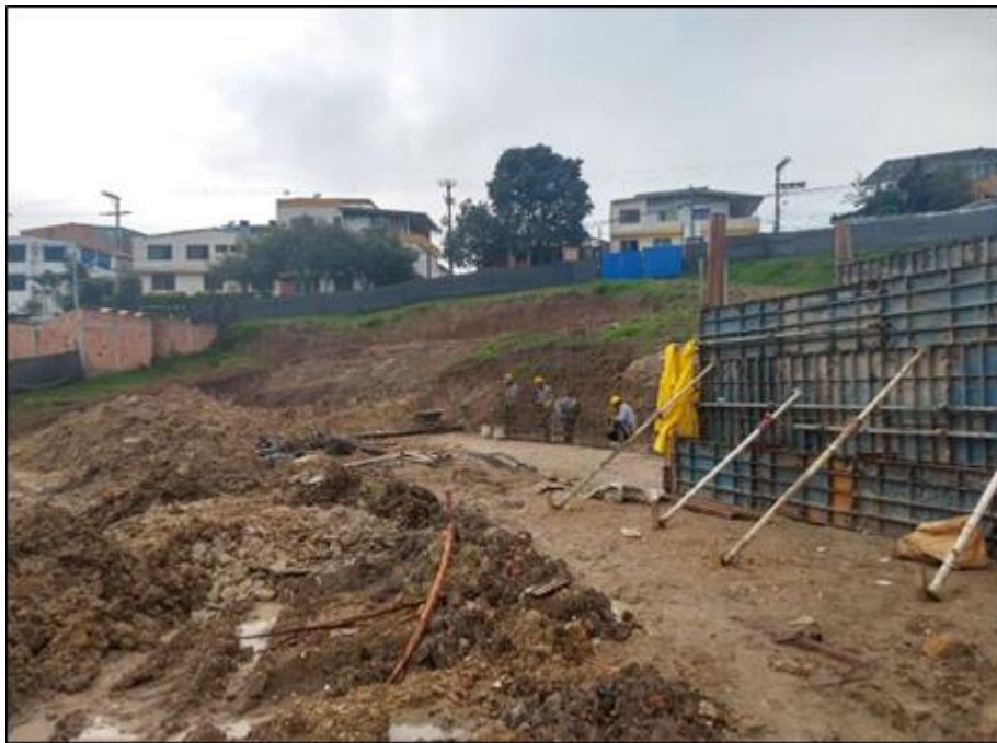
Figura 17. Supervisión del armado de refuerzo muro de contención.
