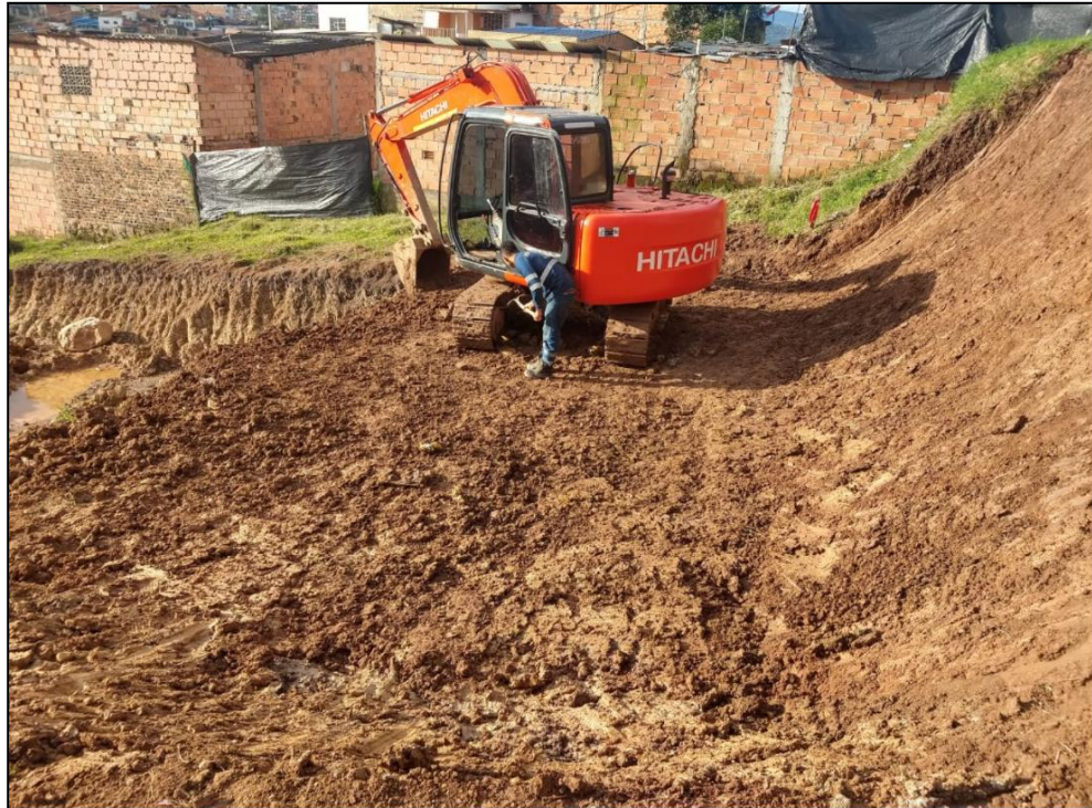
Figura 18. Estabilización de talud colindante con la carrera 8.
