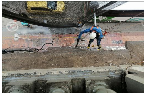
Figura 4. Limpieza de fachada
