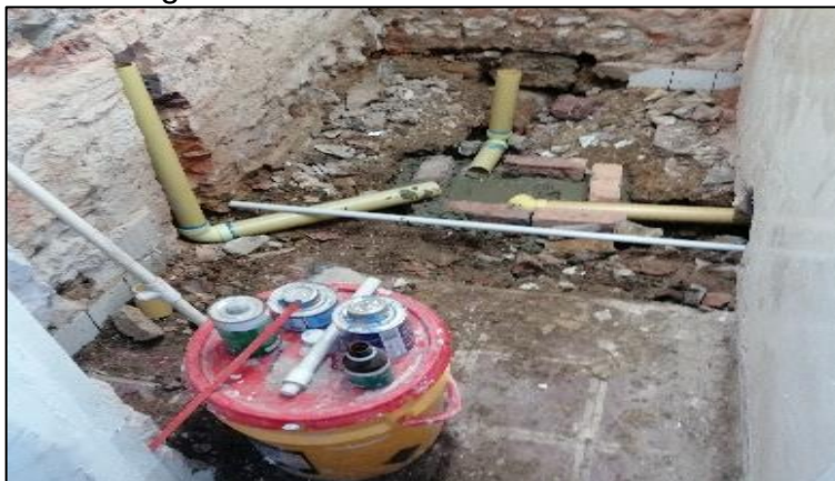
Figura 27. Instalación de tubería PVC
