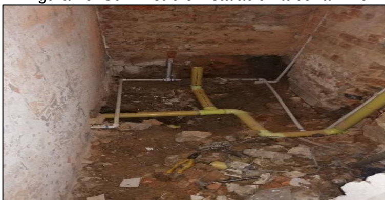
Figura 28. Suministro e instalación tubería PVC
