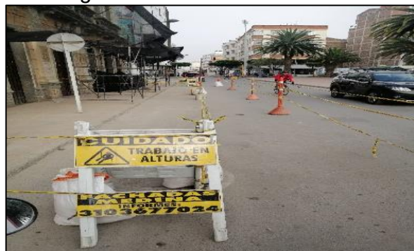
Figura 5. Señalización de obra
