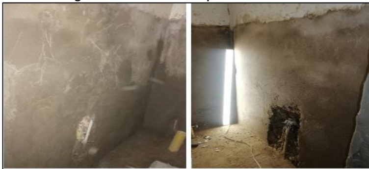
Figura 30. Pañete impermeabilizado.
