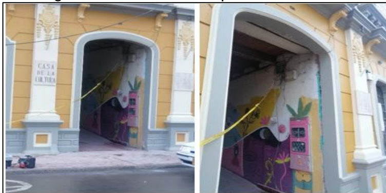
Figura 23. Desmonte de puertas de acceso
