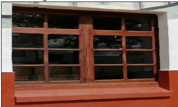
Figura 20. Instalación de vidrios.
