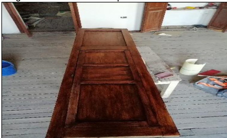
Figura 6. Terminación de puertas en madera cedro
