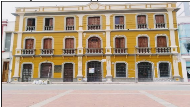
Figura 7. Resanes y pintura de la fachada
