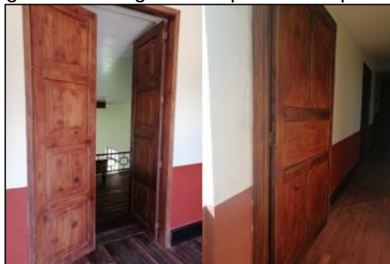
Figura 14. Arreglo de carpintería en puertas
