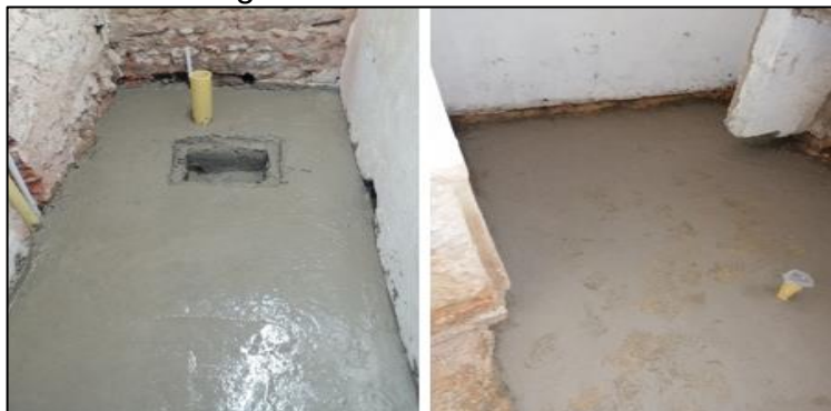
Figura 29. Solado concreto.
