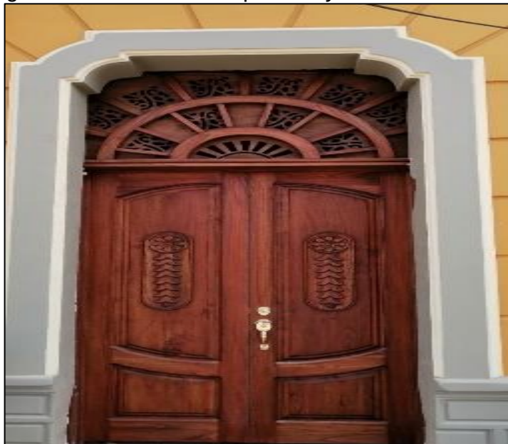
Figura 24. Instalación de puertas y ventanas en cedro
