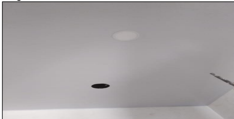
Figura 26. Suministro e instalación cielo raso PVC.
