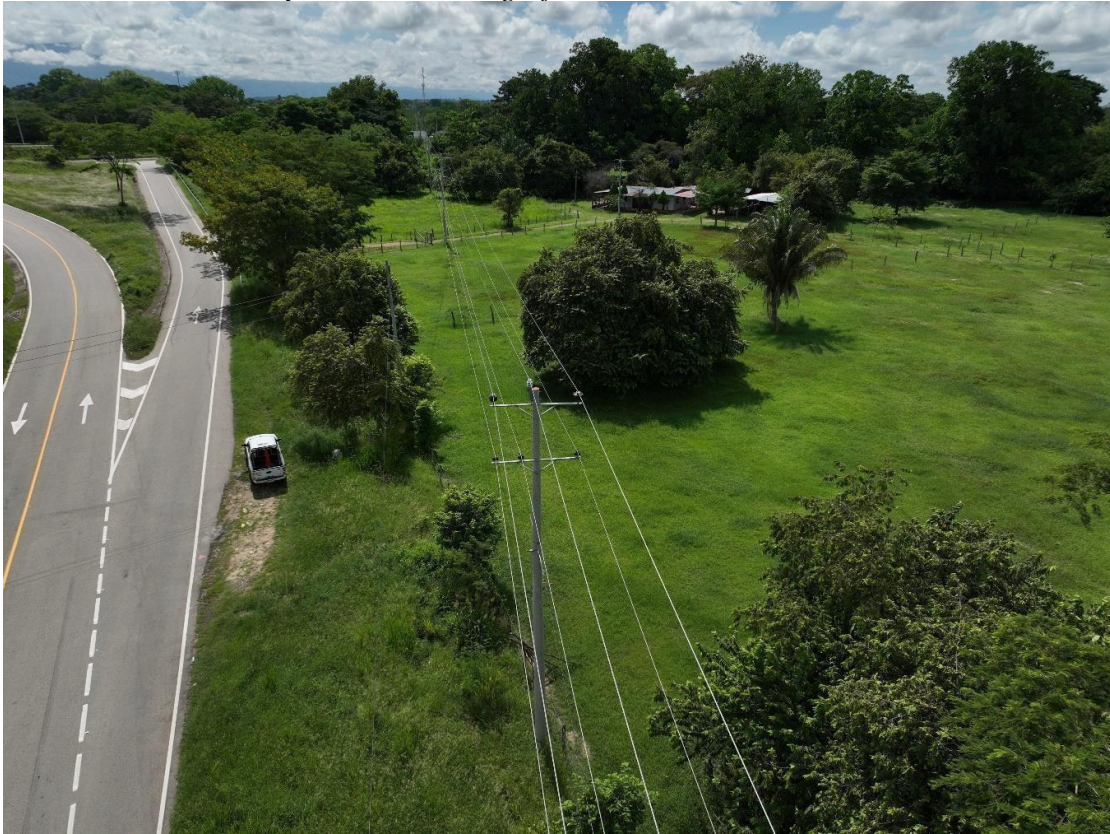
Figura 15. Fotos con dron y cámaras termográficas
