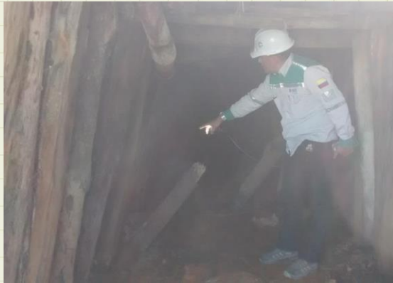
Fotografía tomada al interior del túnel, donde se evidencia las malas condiciones de la madera y el recorrido del drenaje.
