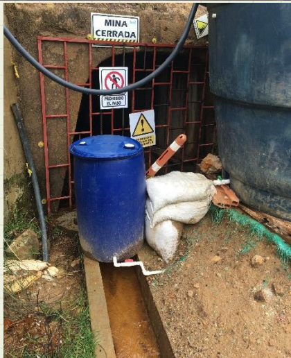
Fotografía tomada en la bocamina, donde se evidencia el canal de drenaje y las condiciones de seguridad del ingreso, de igual manera se observan los tanques de la planta de tratamiento.
