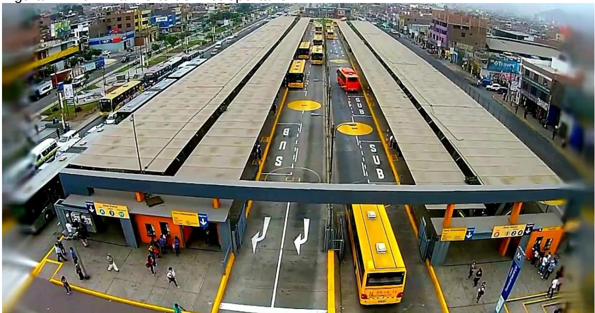
Figura 44. Terminal Norte del Metropolitano.
