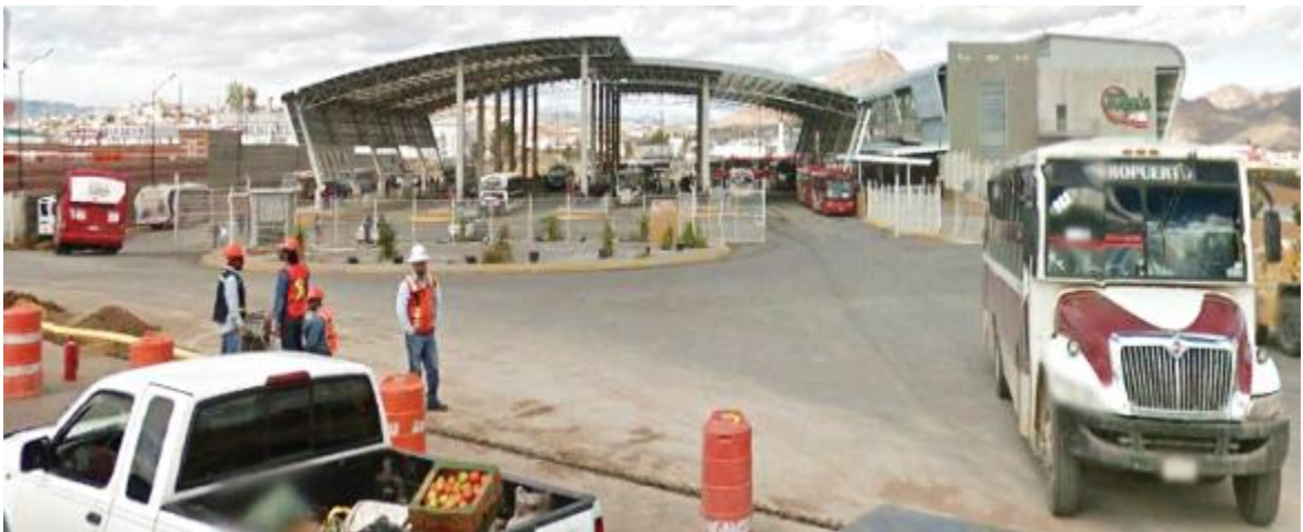
Figura 77. Terminal Juan Pablo II (terminal sur).
