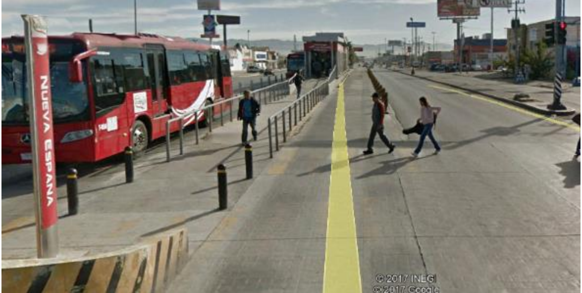
Figura 89. Rampa de ingreso a una estación.
