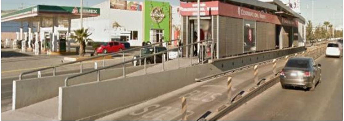
Figura 79. Estación doble Centauro del Norte.
