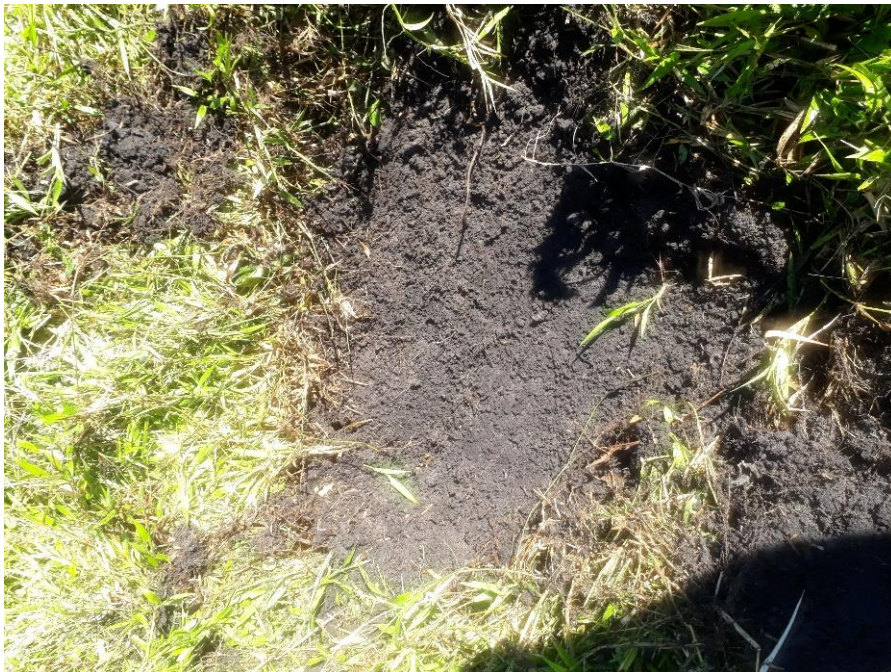
Fotografía 2. Limpieza de superficie del suelo, por Jhon K. Ramírez, 2020.
