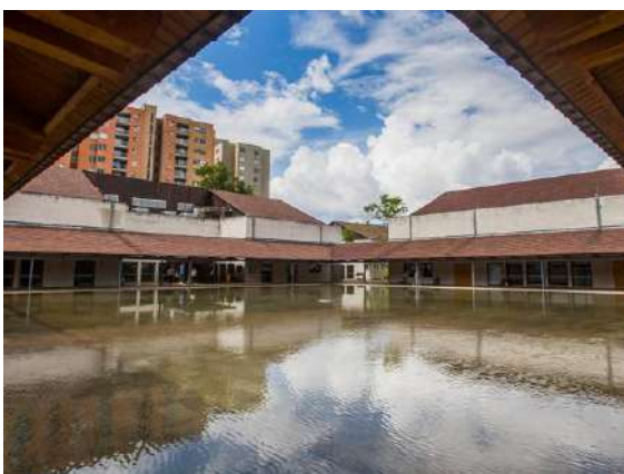
TELA DE AGUA / PATIO CENTRAL
