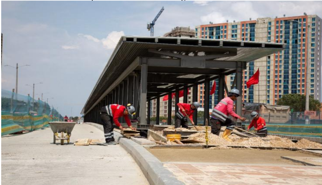
Figura 2. Construcción rutas para Transmilenio con gd
