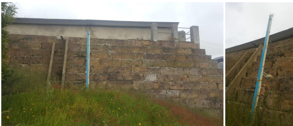
Figura 11. Actual sistema de medición de nivel de llenado en tanques. Nota: elaboración propia.
