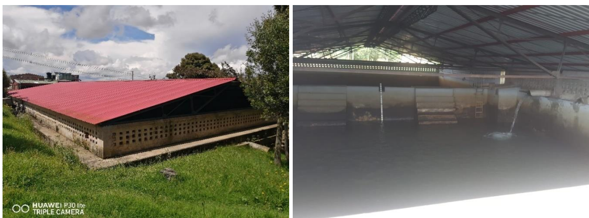
Figura 10. Tanque Gemelos Cuadrados. Nota: elaboración propia
