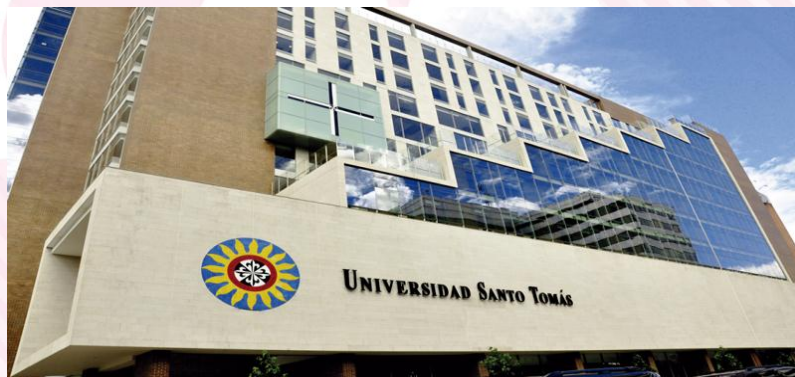
Ilustración 4. Edificios de Chapinero
