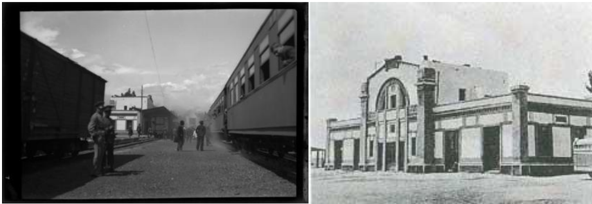
Figura 10 Estación del ferrocarril
