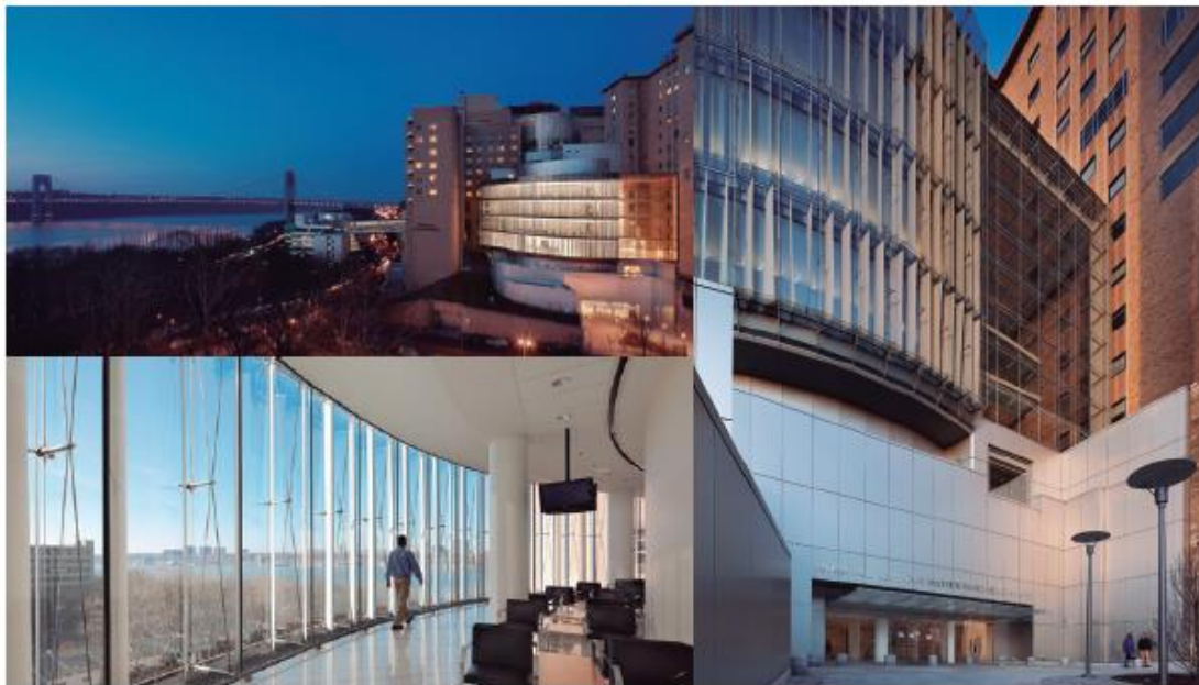
Figura 46 Imágenes Fachada cortina
