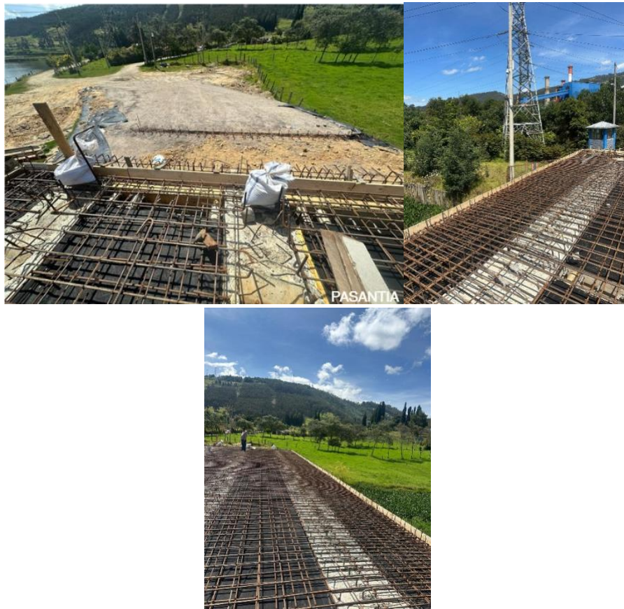
Fig. 22. Encofrado perimetral
