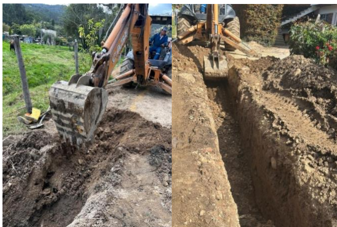
Fig. 27. Excavación de zanjas
