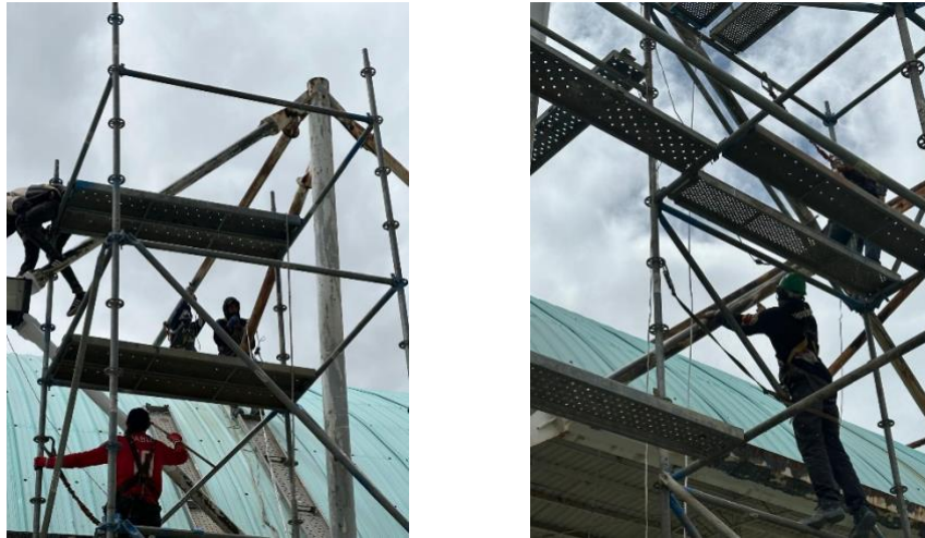
Fig. 10. Armado de andamio
