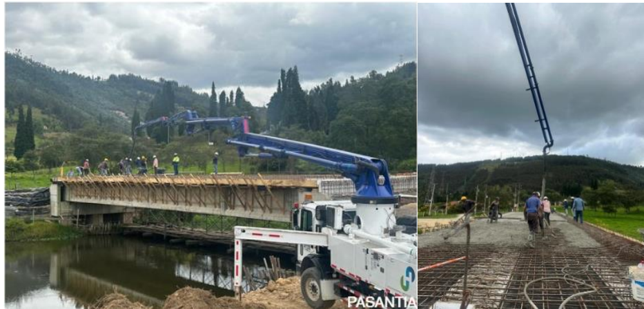
Fig. 23. Proceso de fundición del tablero superior
