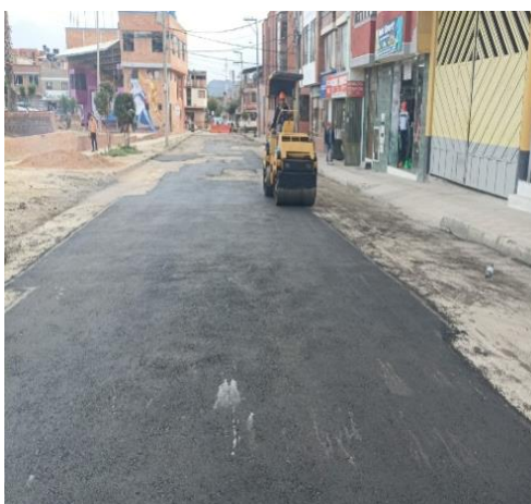
Fig. 8. Compactación de la mezcla asfáltica
