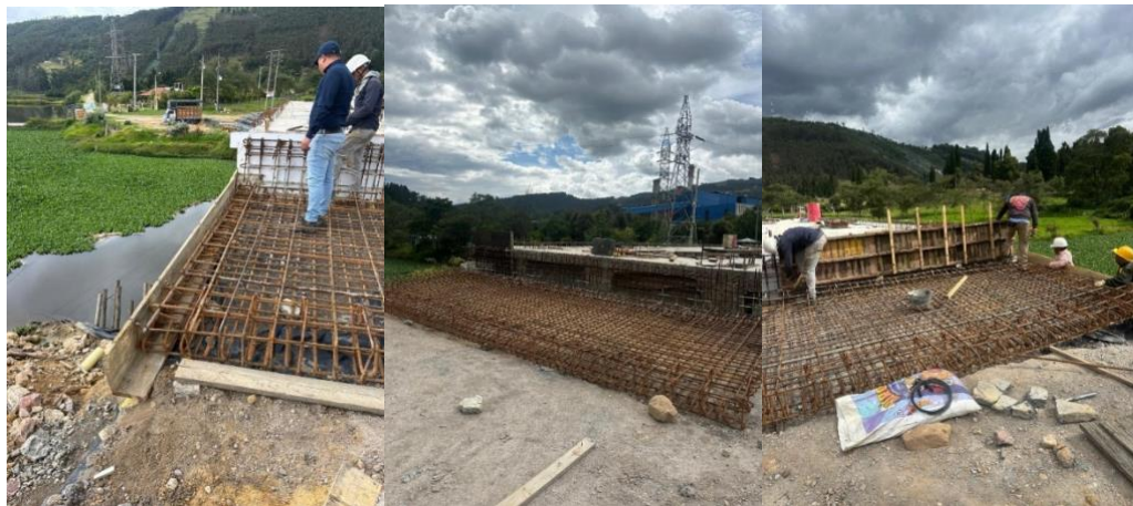
Fig. 25. Armado de losas de aproximación
