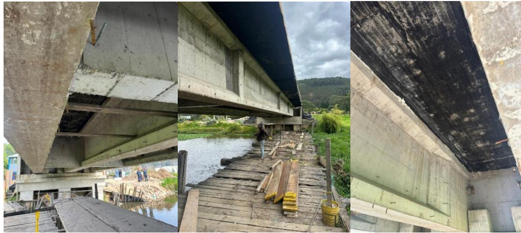
Fig. 24. Desenformado
