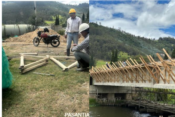
Fig. 19. Armado de pie de rey
