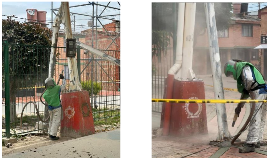
Fig. 12. Sandblasting
