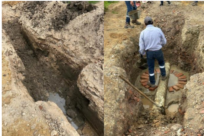
Fig. 29. Pozos de inspección
