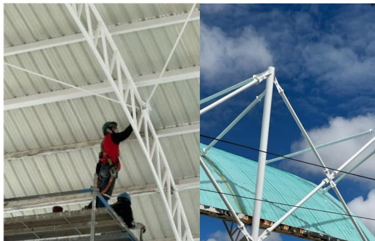
Fig. 14. Aplicación pintura tipo super esmalte 4 en 1
