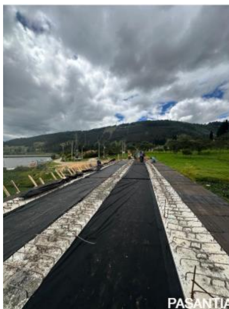
Fig. 20. Colocación del polipropileno
