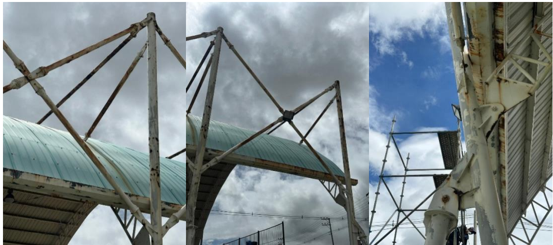
Fig. 9. Estado inicial de la estructura (Columnas, cerchas y uniones)
