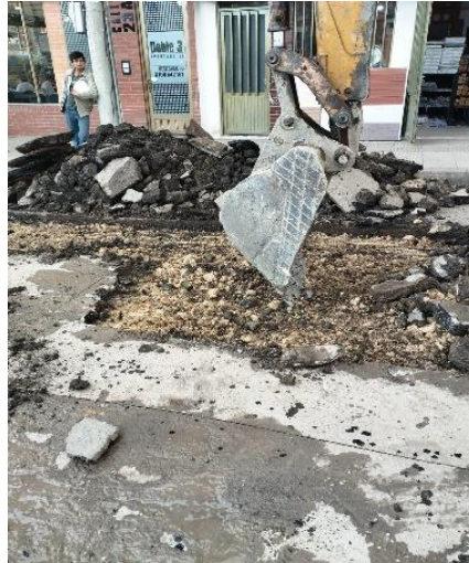
Fig. 5. Remoción de pavimento deteriorado para intervención localizada
