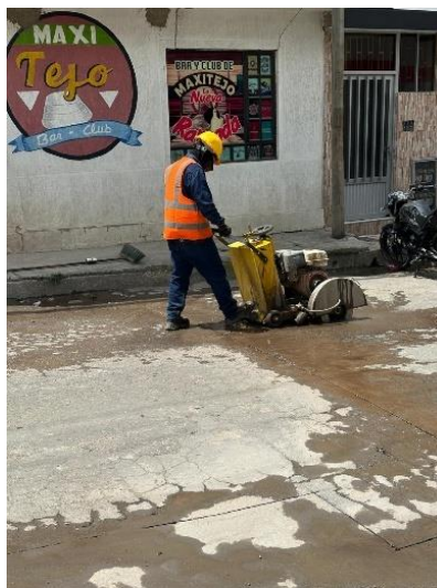
Fig. 4. Corte malla vial
