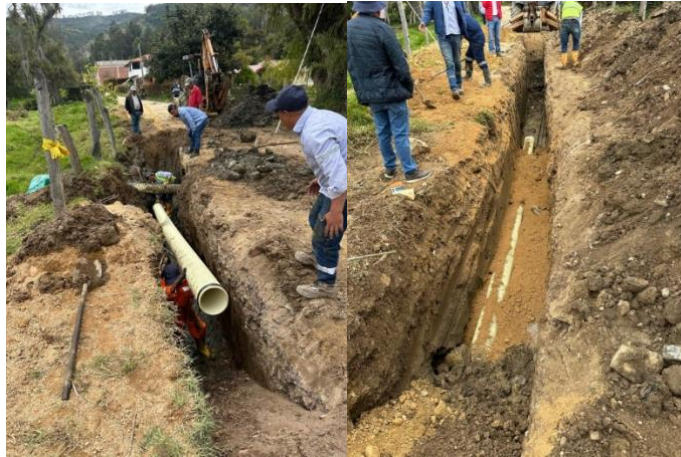
Fig. 28. Instalación de tubería y relleno
