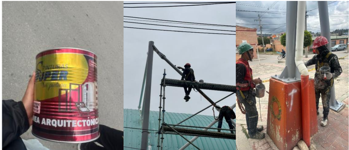
Fig. 13. Aplicación de anticorrosivo
