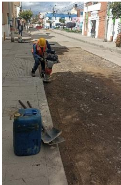
Fig. 6. Reemplazo de base granular en zona intervenida
