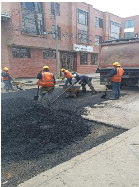
Fig. 7. Colocación de mezcla asfáltica en zonas intervenidas
