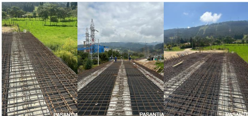
Fig. 21. Armado del acero del tablero
