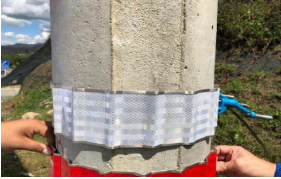
Cinta retro reflectiva conspicuity en poste de concreto, instalada a la altura del pecho (1,60m)
