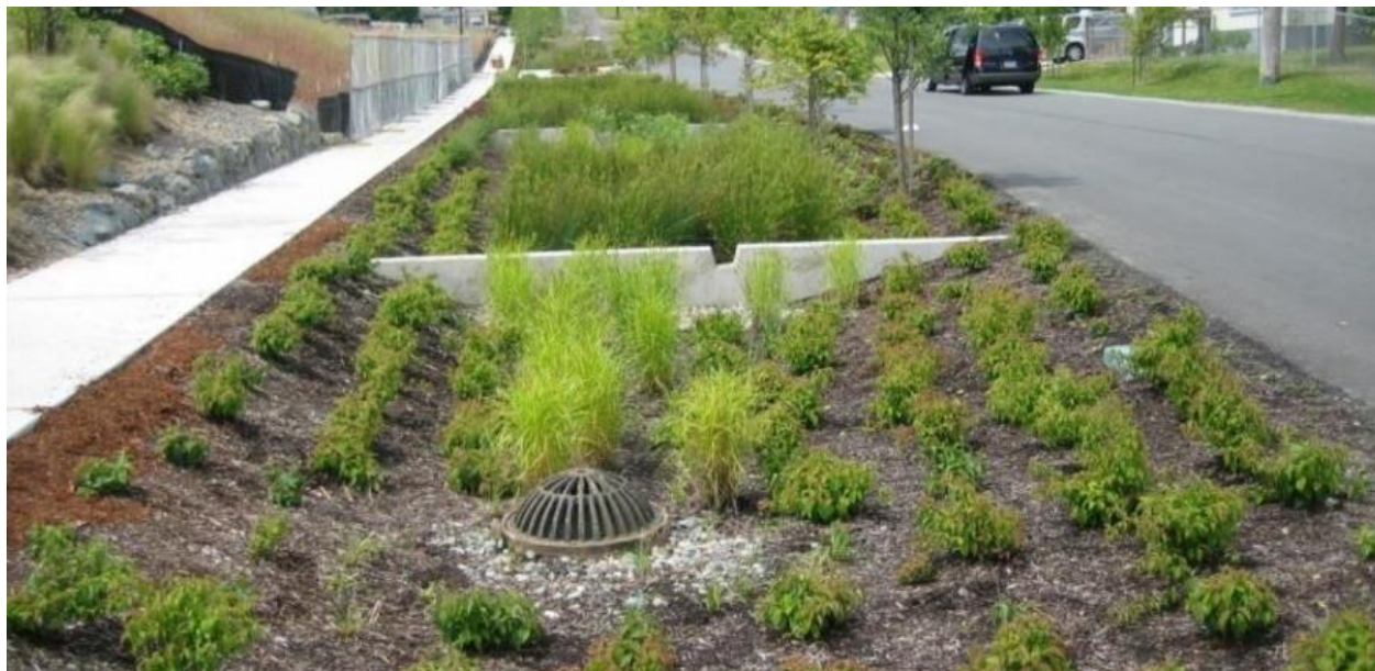
Figura 10. Zonas de biorretención laterales a una avenida
