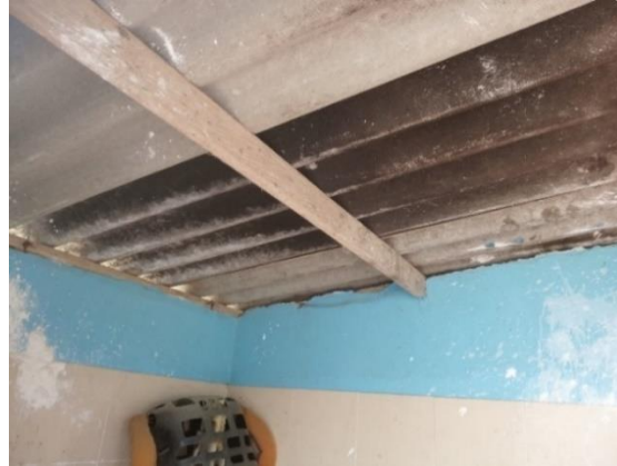
Figura 6. Techo del centro de almacenamiento de residuos peligrosos.
