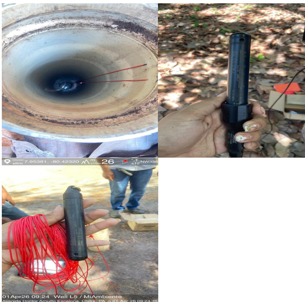
Fotografía 1. Instalación de transductores de presión.
