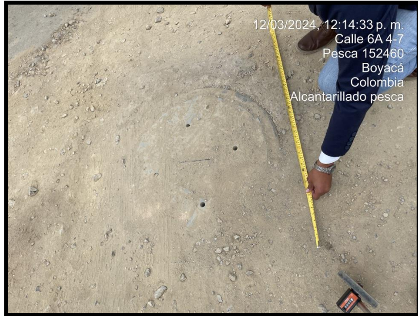
Figura 9. Visita de campo medición alcantarillado municipio de Pesca - Boyacá
