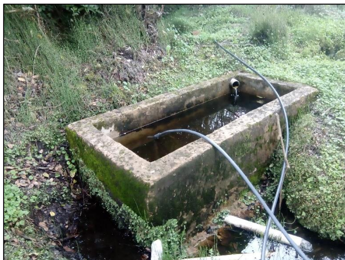
Ilustración 26. Verificación estado bocatoma-vereda Barón Germania
