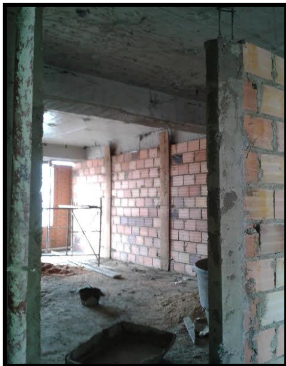
Figura 22. Mampostería en bloque para muros divisorios.
