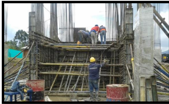
Figura 20. Formaleta y arriostramiento de pantalla
