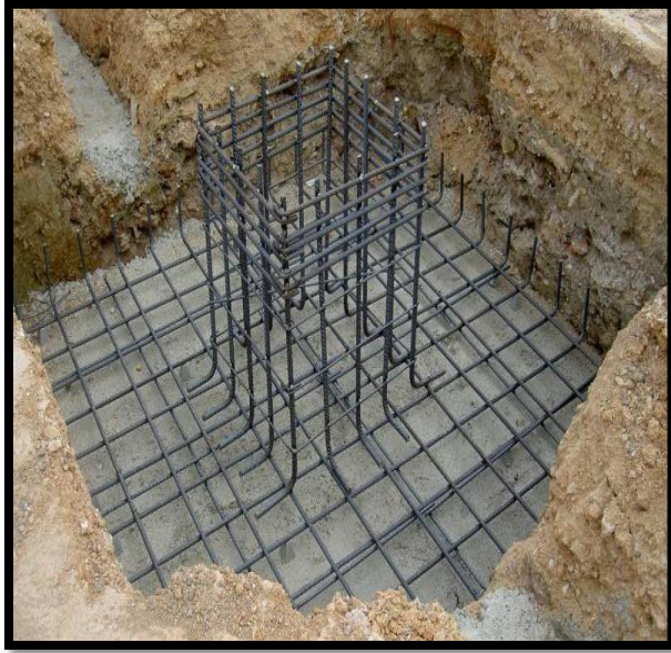
Figura 12. Zapatas aisladas
