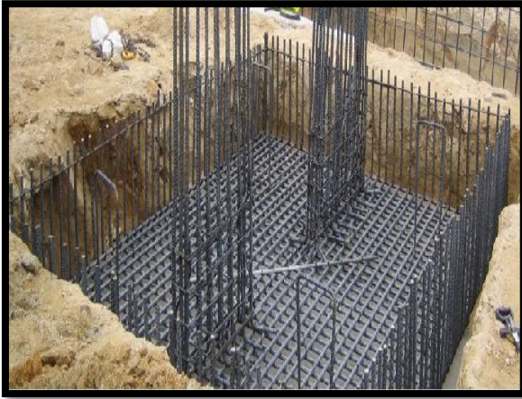
Figura 14. Zapatas combinadas
