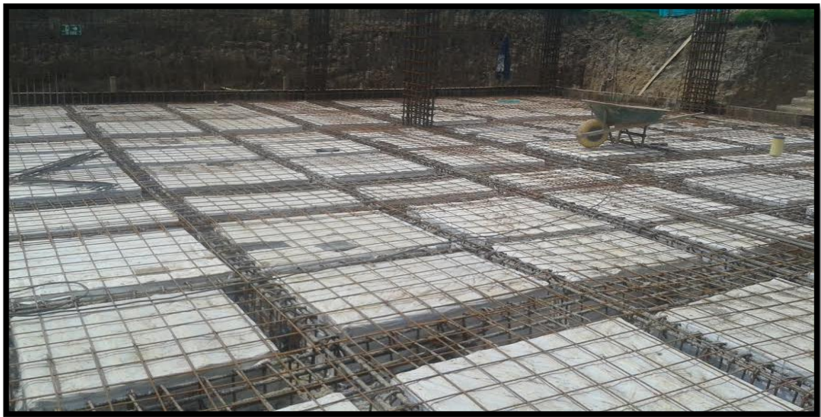
Figura 15. Losas de cimentación.
