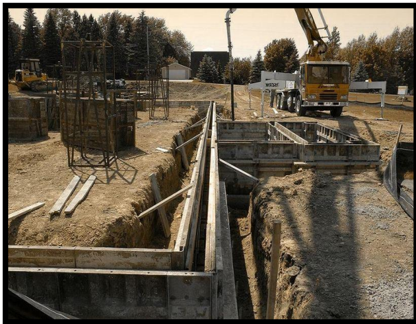
Figura 13. Zapatas corridas
