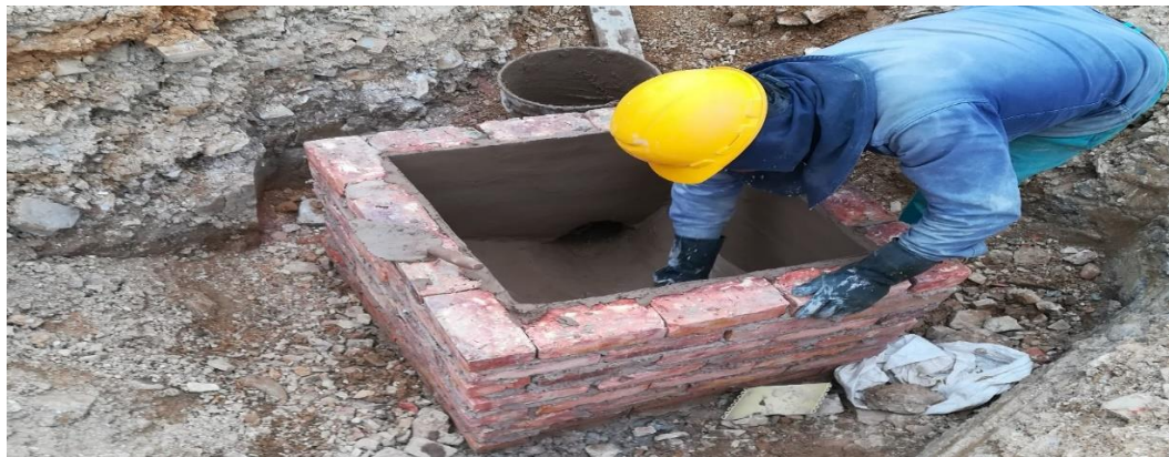
Fotografía 14. Construcción de cajas de inspección
