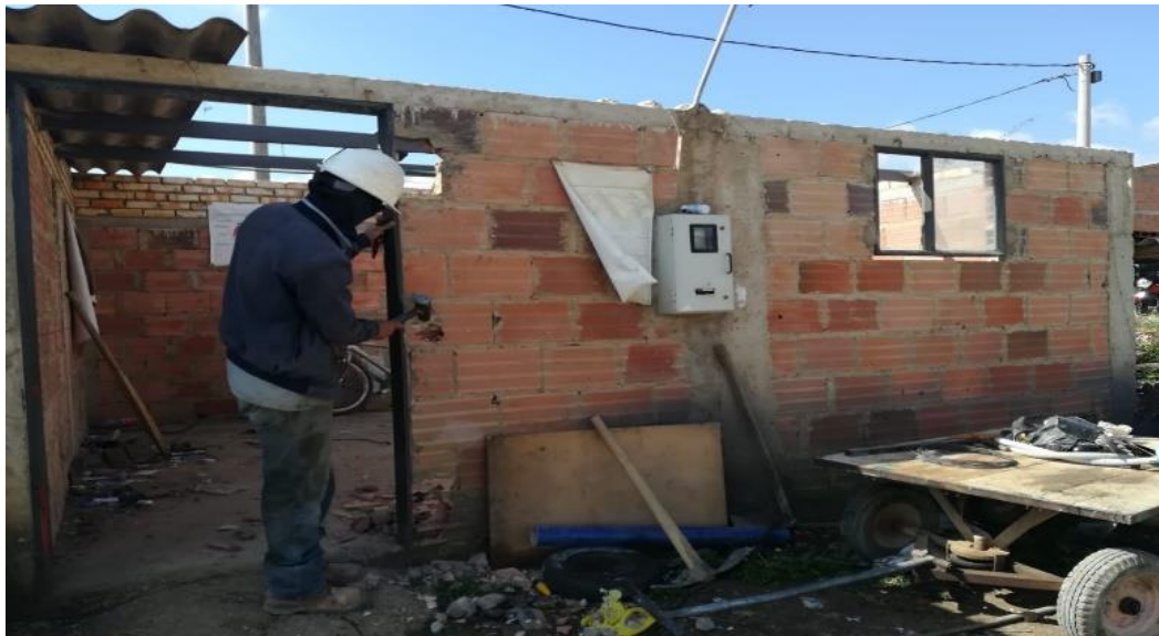
Fotografía 46. Demolición de casa campamento, las Quitas.
