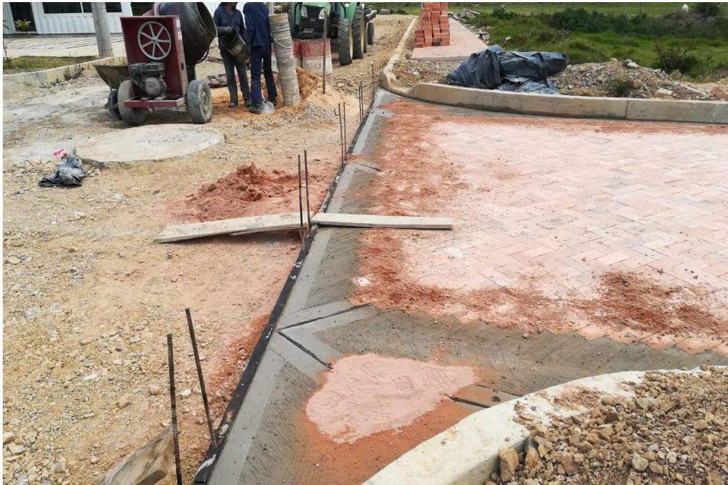
Fotografía 35. Proceso y fundida de correas y cunetas.
