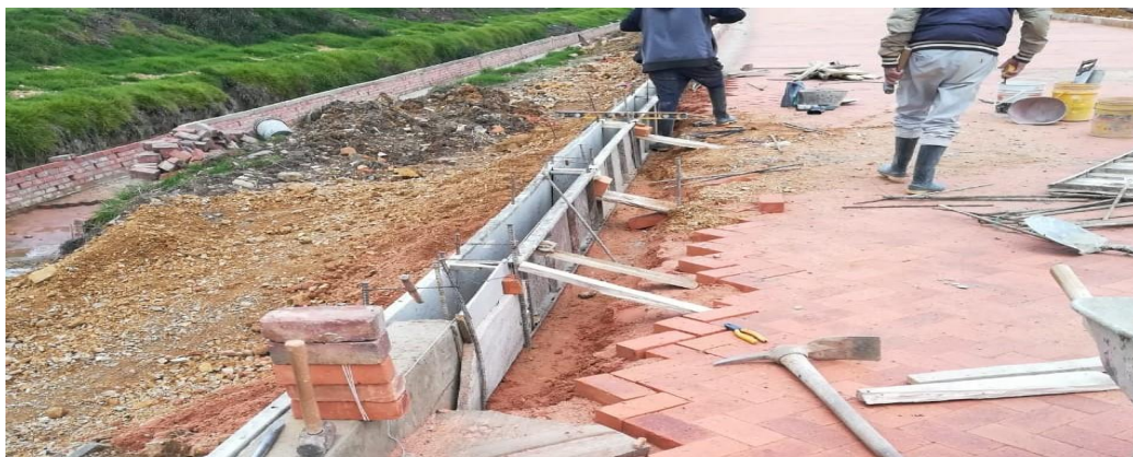
Fotografía 41. Reparaciones de infraestructura vial.
