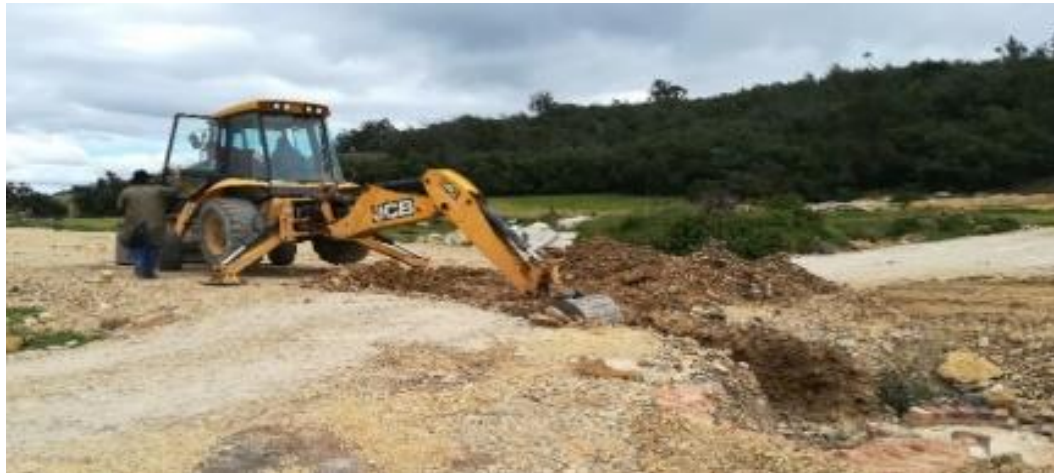
Fotografía 10. Excavación mecánica (zanja)
