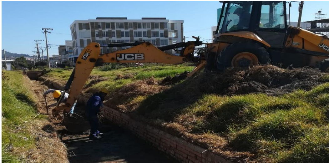
Fotografía 20. Mantenimiento de canal aguas pluviales.
