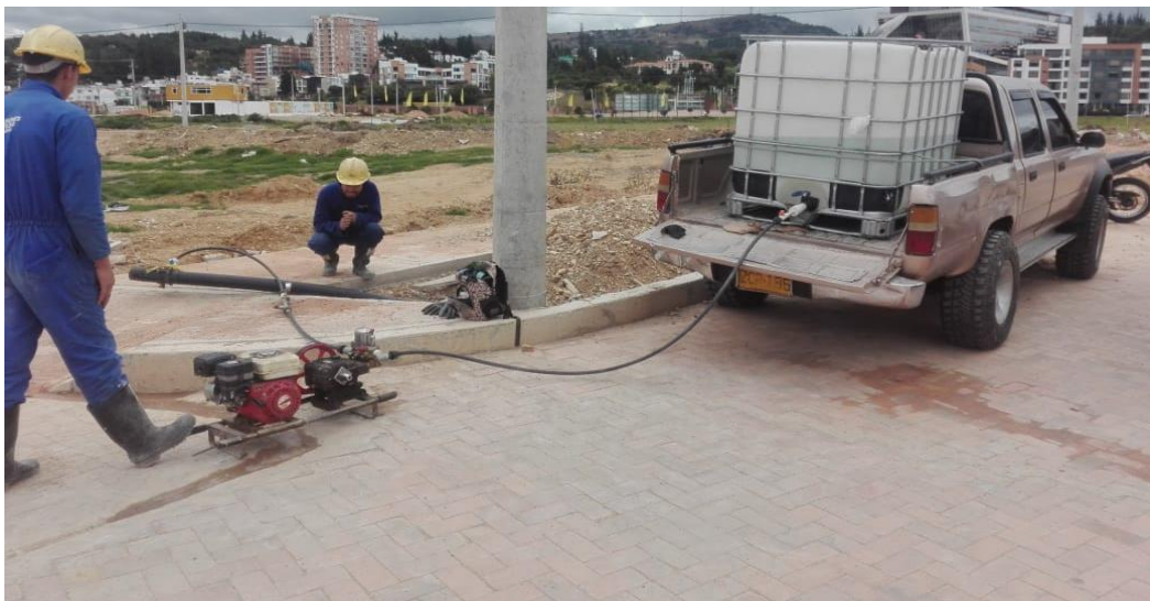
Fotografía 23. Prueba de Presión Hidrostática – Red de acueducto.
