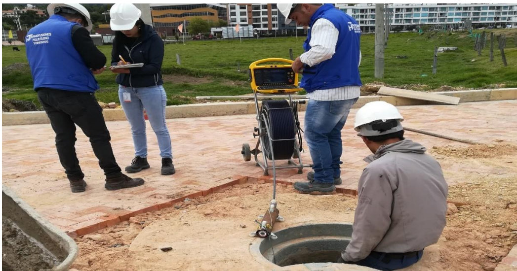
Fotografía 18. Inspección con cámara (Pozos-Tubería de alcantarillado)
