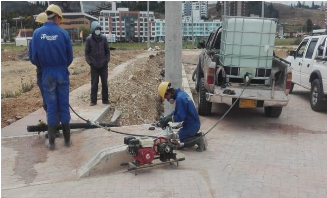
Fotografía 24. Prueba de desinfección.
