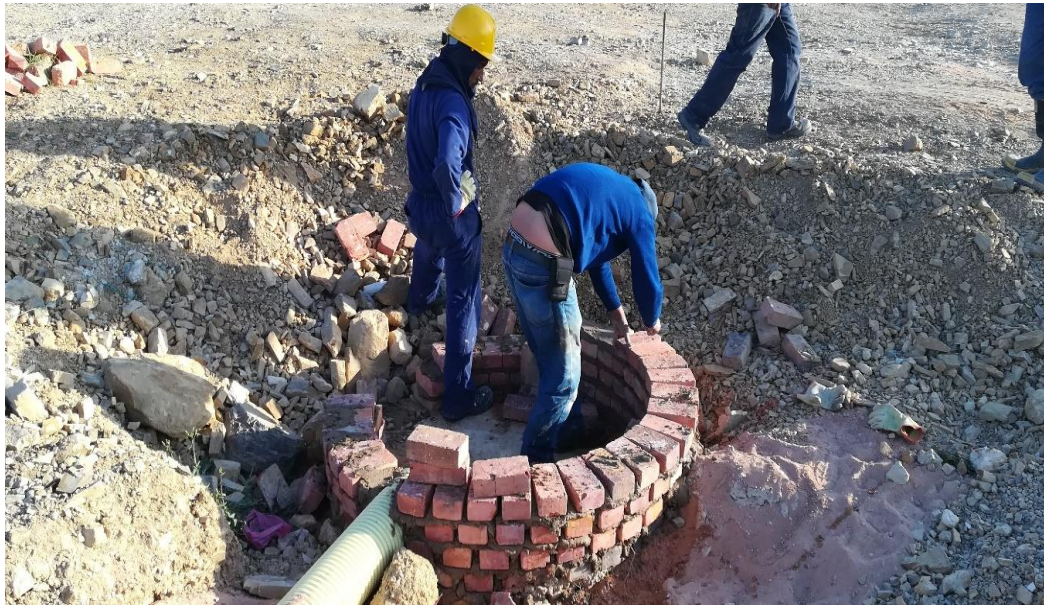
Fotografía 15. Construcción de pozos de inspección
