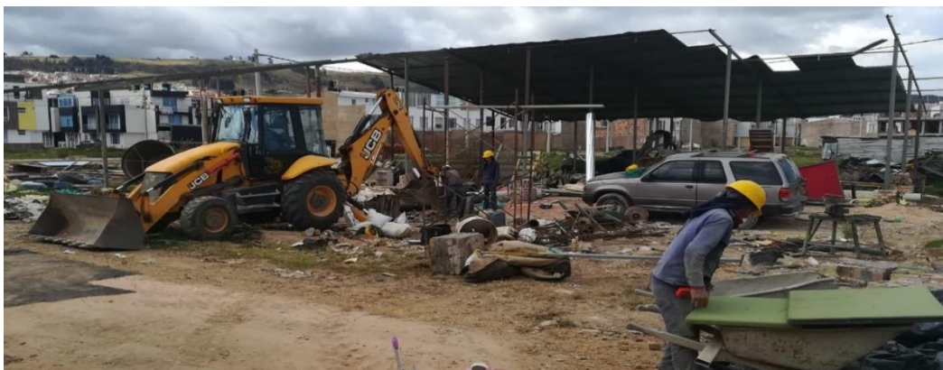
Fotografía 45. Desarme de estructura campamento las Quintas.
