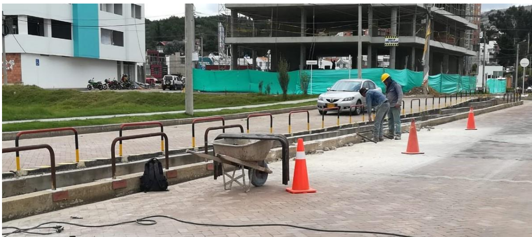
Fotografía 21. Instalación de barandas anti choques.
