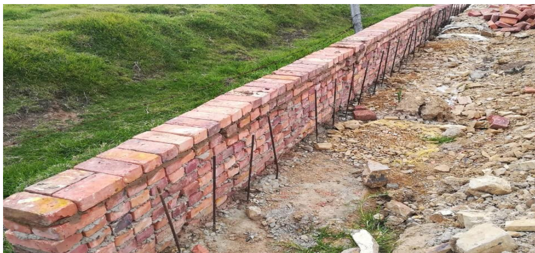
Fotografía 38. Muro de contención de zapata continua en mampostería.
