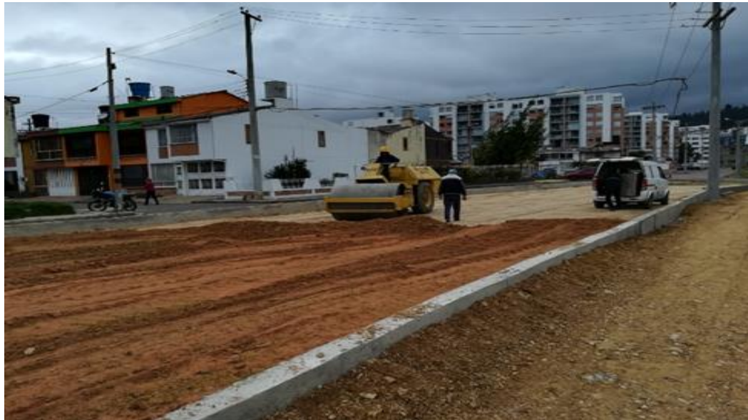
Fotografía 28. Aplicación de sub-base y base, estructura vial
