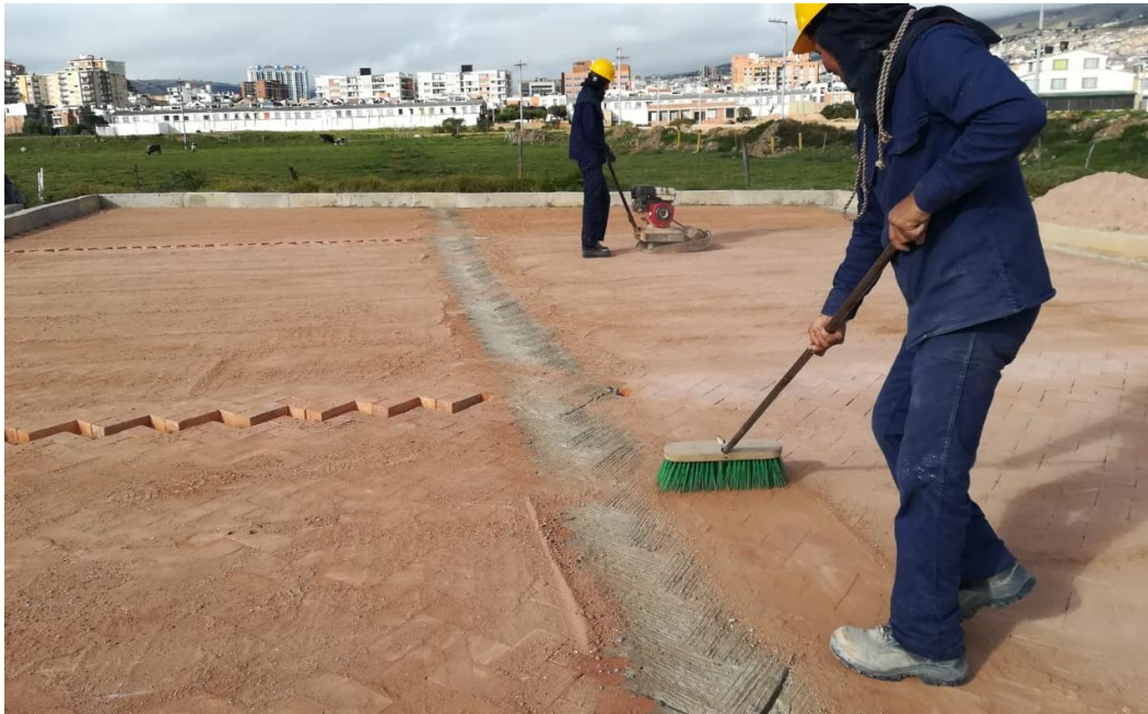
Fotografía 36. Sellado de juntas en pavimento
