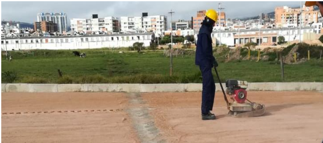
Fotografía 37. Proceso de compactación en pavimento
