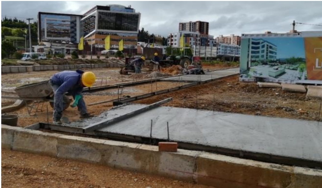
Fotografía 25. Construcción de andenes
