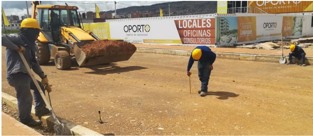
Fotografía 30. Replanteo y nivelación de la base, estructura vial.
