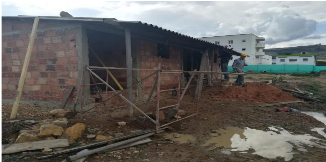
Fotografía 43. Construcción de campamento
