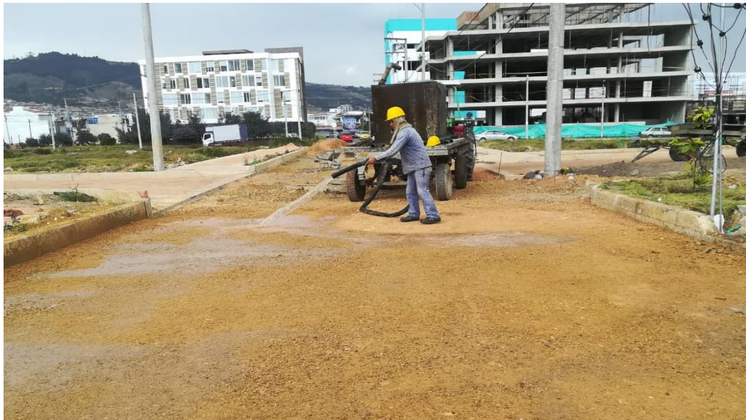
Fotografía 32. Aplicación de humedad por riego
