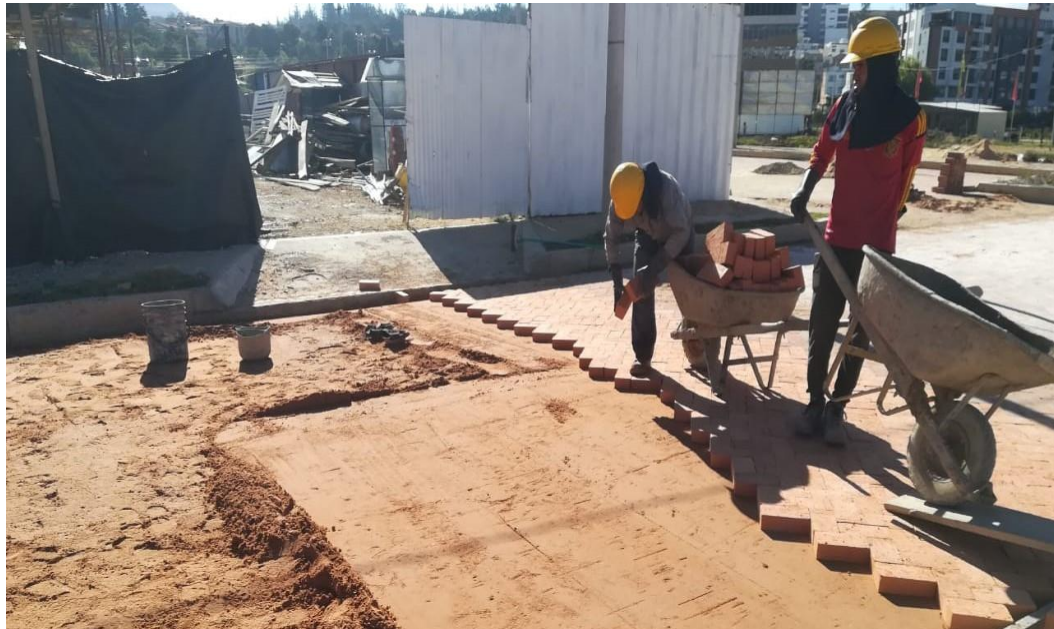
Fotografía 34. Instalación de pavimento (Adoquín)
