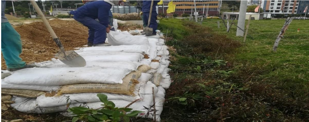
Fotografía 40. Muro de contención en lonas de recebo
