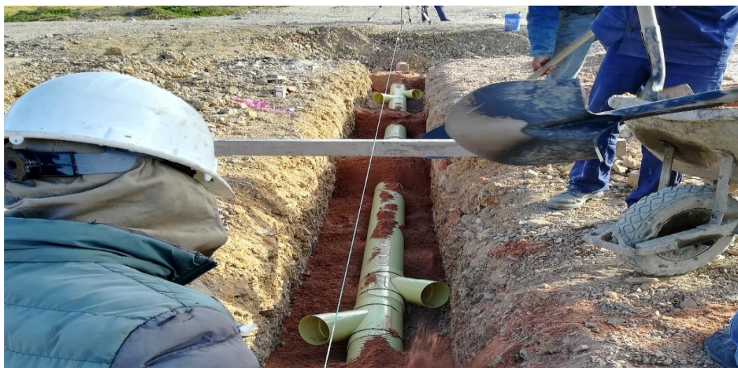
Fotografía 13. Conexiones de tubería de alcantarillado
