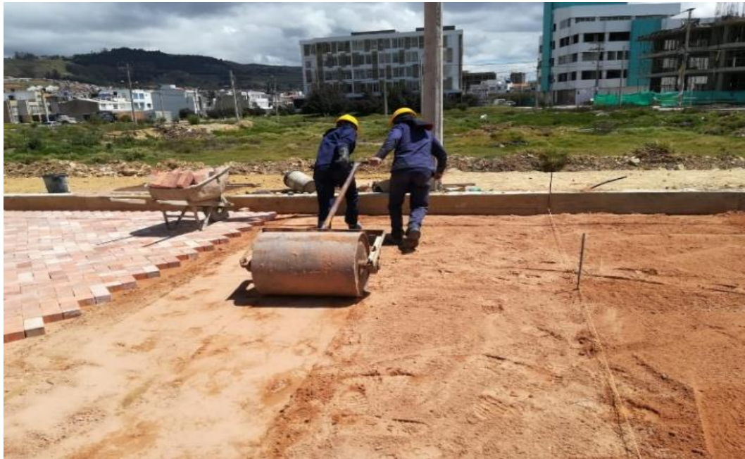
Fotografía 33. Elaboración de capa de arena, estructura vial.
