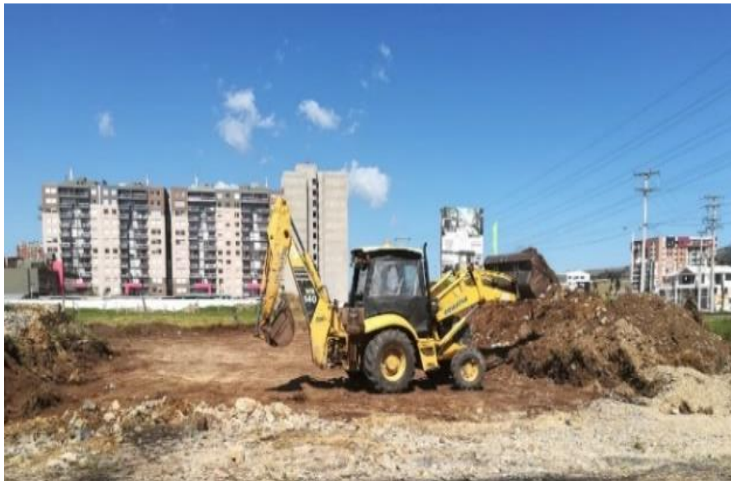
Fotografía 27. Replanteo y nivelación de Sub-Rasante, estructura vial
