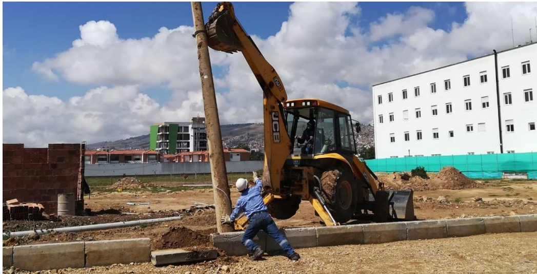
Fotografía 42. Instalación de alumbrado público.
