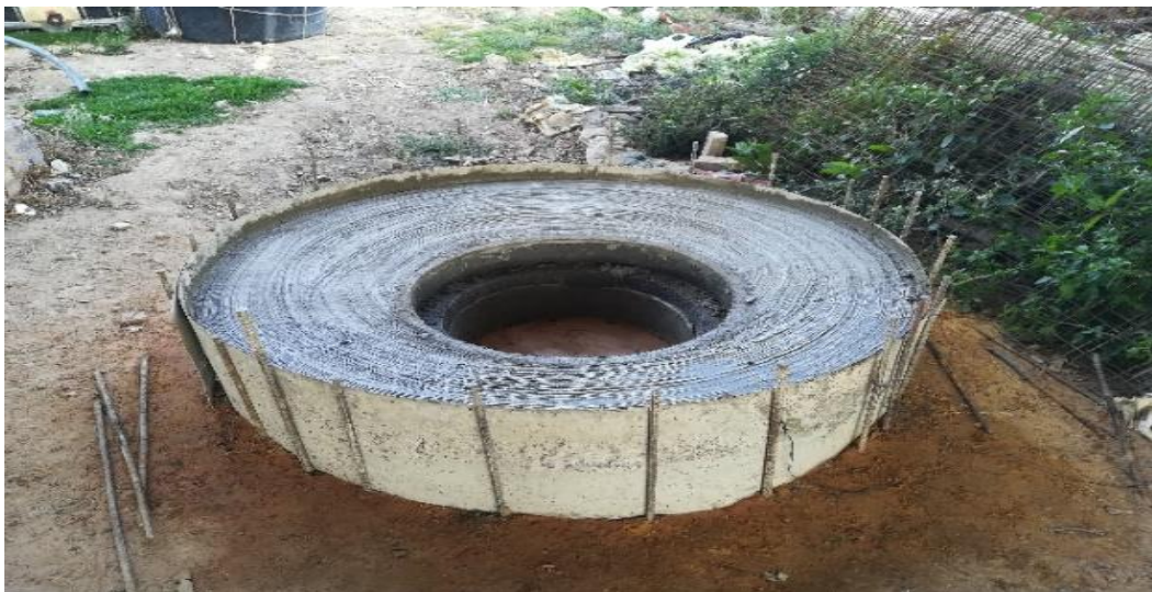
Fotografía 17. Proceso de fundida
