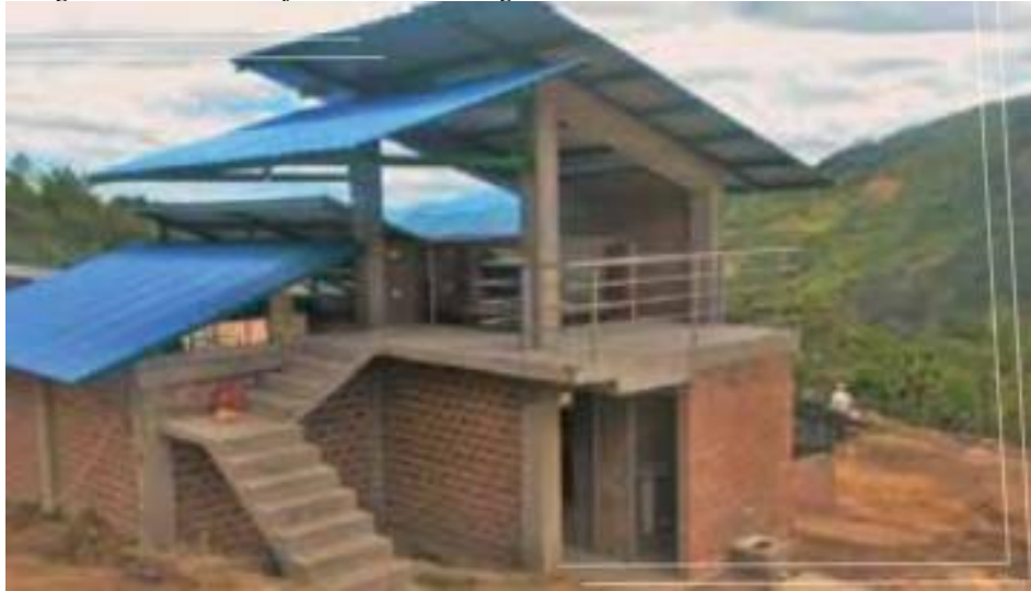
Figura 17. Vista general del beneficiadero ecológico comunitario de San Lorezo
