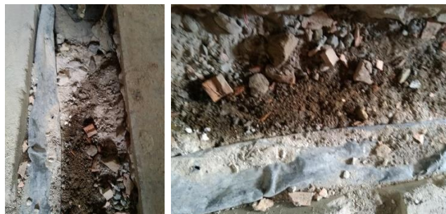
Ilustración 27. Cimentación paciente (concreto ciclópeo)
