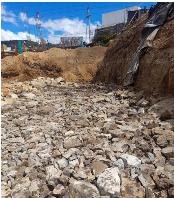
Figura 26. Extendida de rajón en Amalfi – Alcabama.
