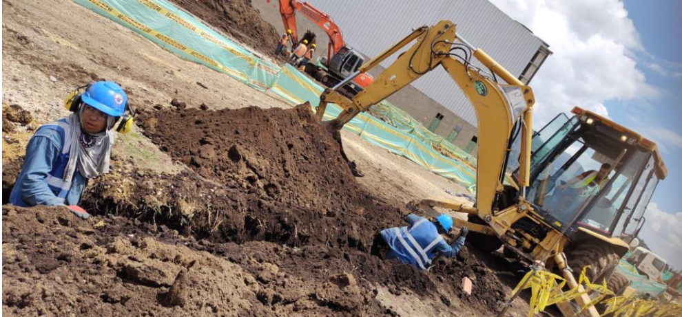
Figura 25. Excavación de zanja con retroexcavadora tipo pajarita CAT 420d IT
