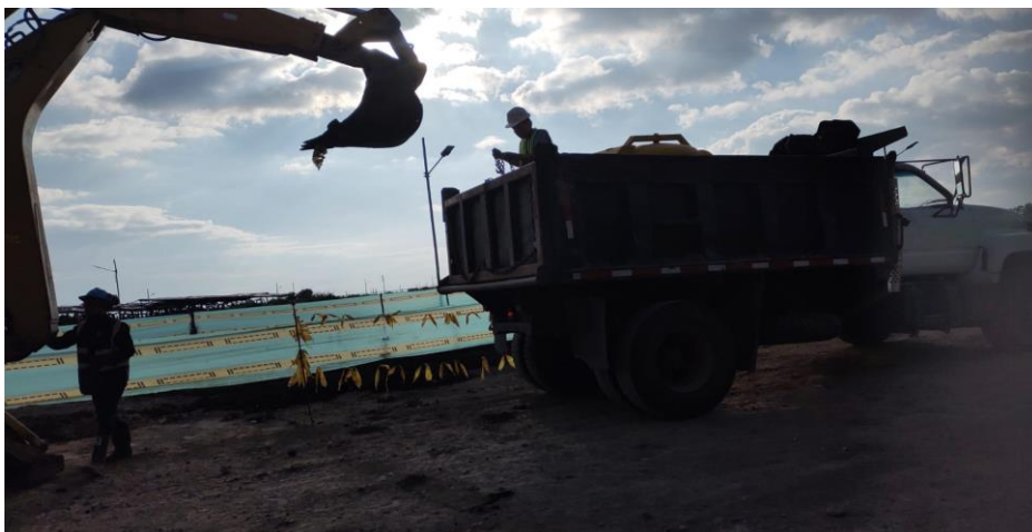
Figura 20. Descargue de equipos y material llevados a la obra
