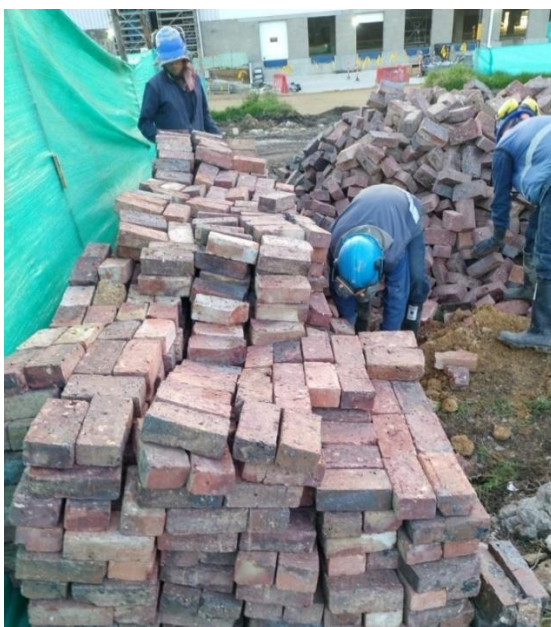
Figura 22. Acopio de ladrillos
