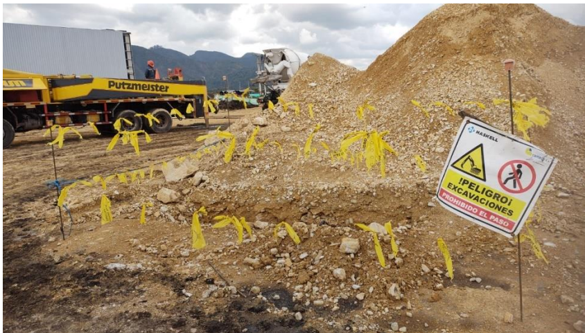
Figura 21. Acopio de agregados en la obra
