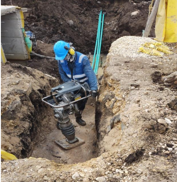
Figura 23. Tramo de box culvert
