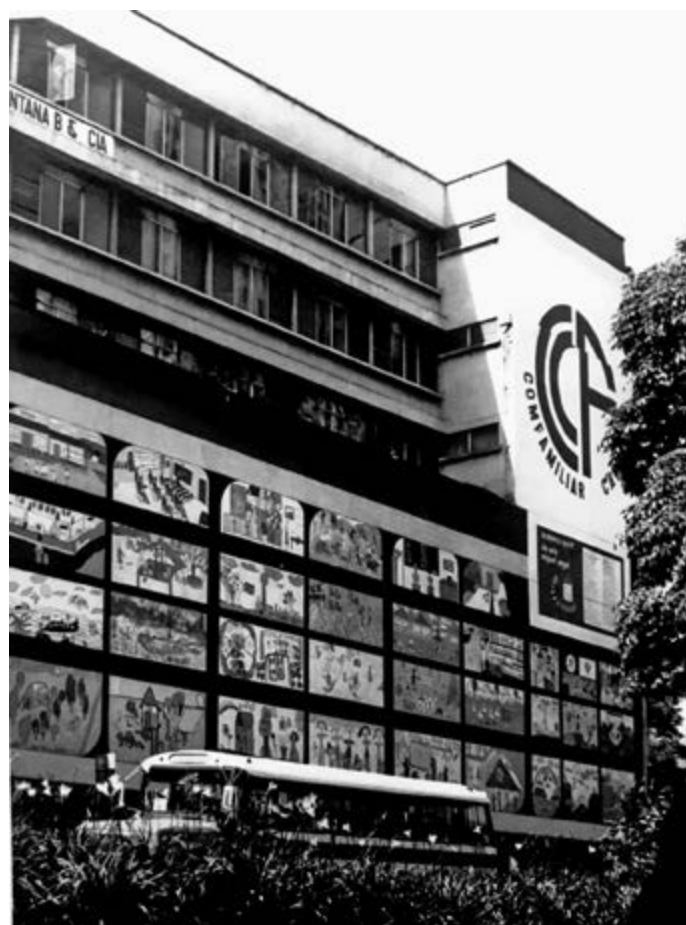
Figura 129. Propuesta de mural en el antiguo edificio del Banco Popular con temática de edificios demolidos del Parque Berrío Nota: edificio demolido posteriormente para la construcción del Metro de Medellín.
