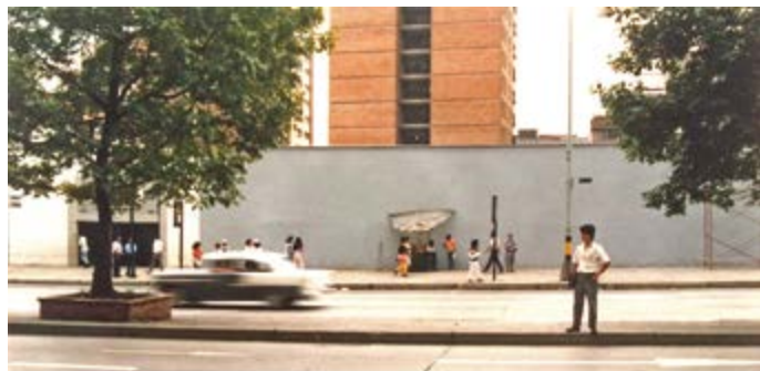
Figura 25. Muro revocado y preparado para la ejecución del mural del Palacio Arzobispal
