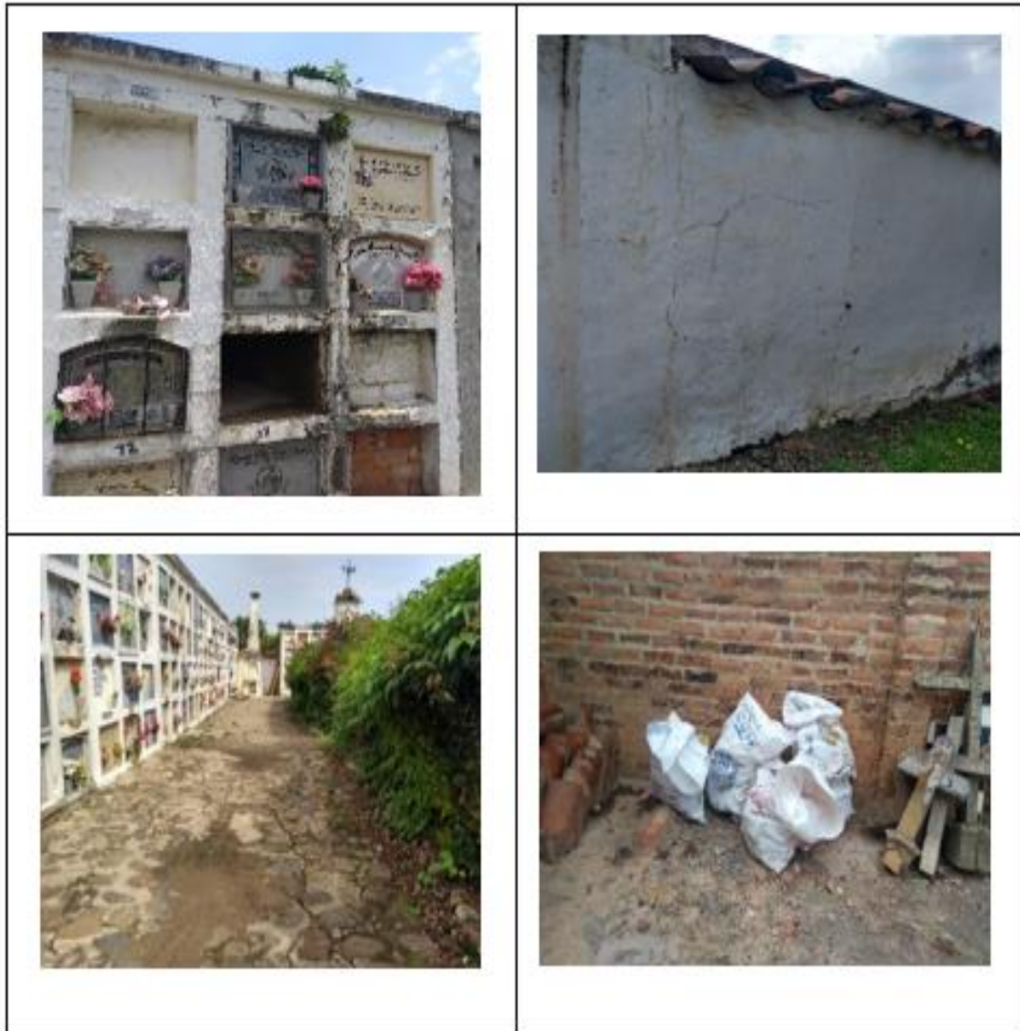
Imagen 6. Estructuras del cementerio parroquial.
