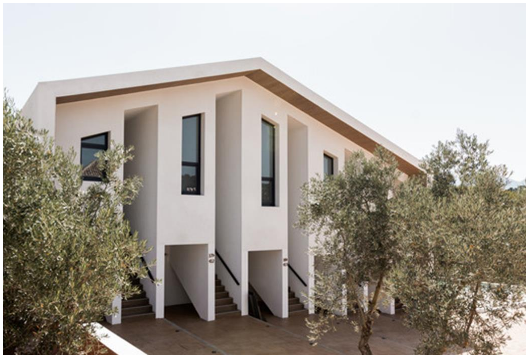
Figura 46. Fachada Hotel Rural El Olivar
