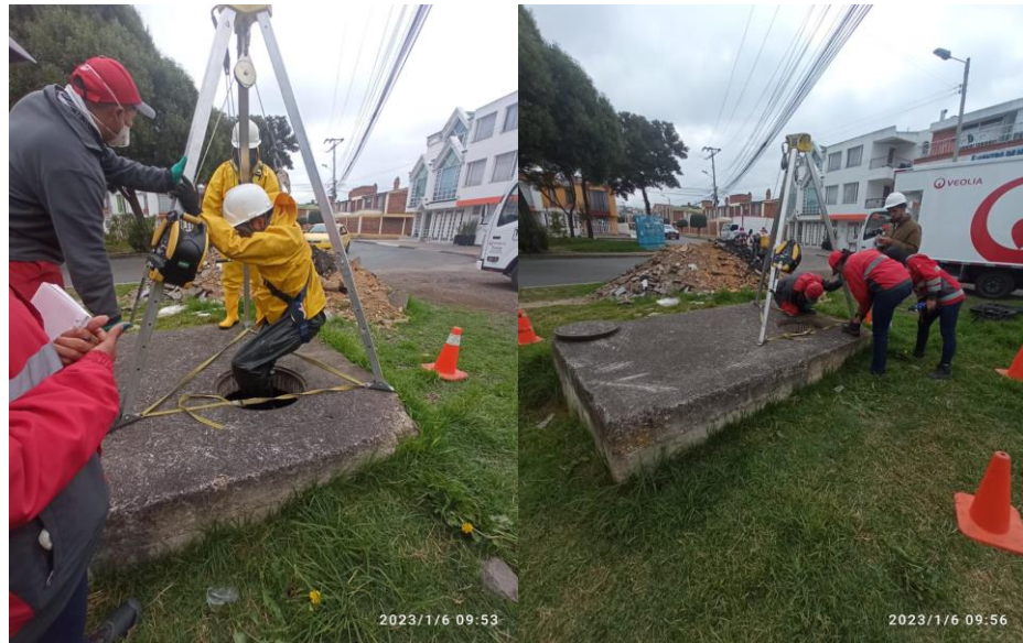
Ilustración 12 Inspección de campo estructura de alivio
