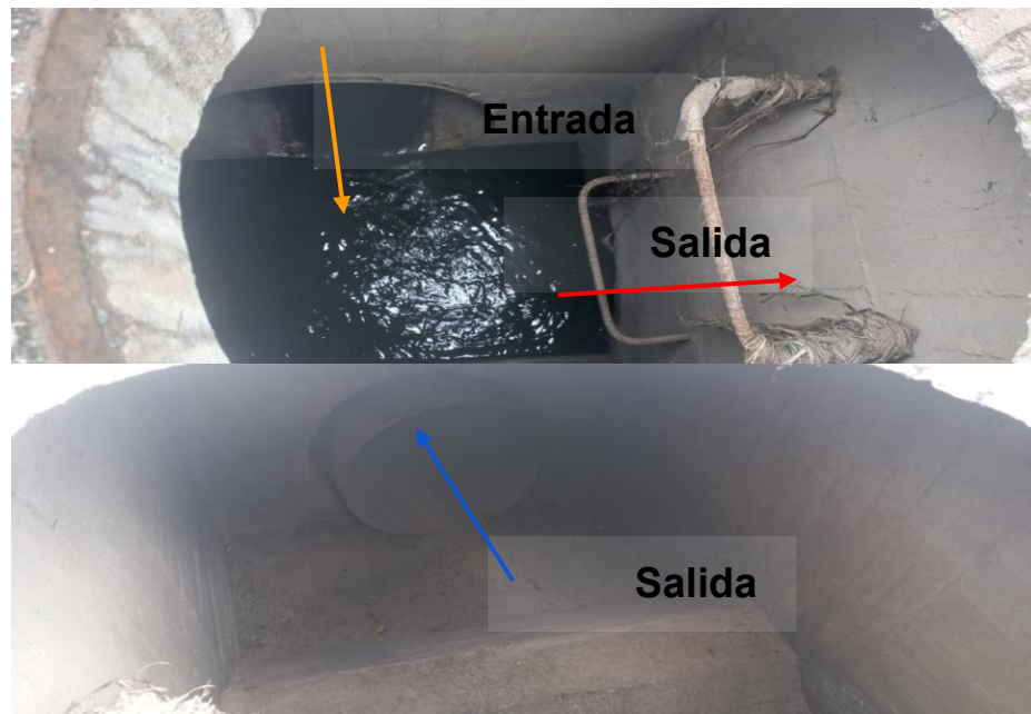
Ilustración 13 Estructura de alivio
