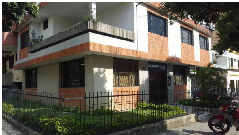
Figura 5. Sede administrativa TECNOPAVIMENTOS S.A
