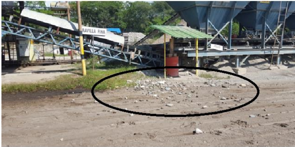
Figura 28. Derrame en llenado de tolvas
