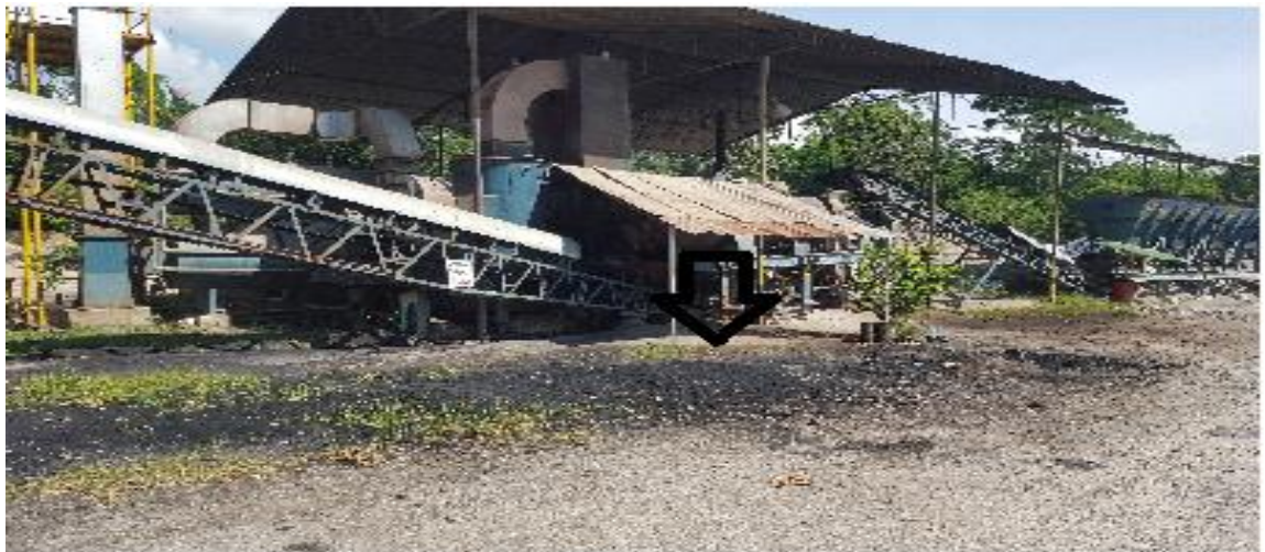
Figura 29. Derrame de mezcla asfáltica
