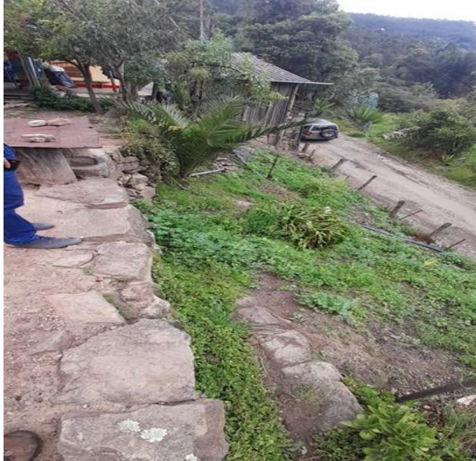
Figura 21. Visita de inspección a vivienda
