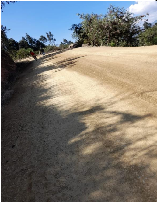
Figura 10. Inspección Proceso constructivo de la carretera y agregados
