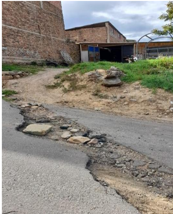
Figura 11. Fracturas presentadas en vías
