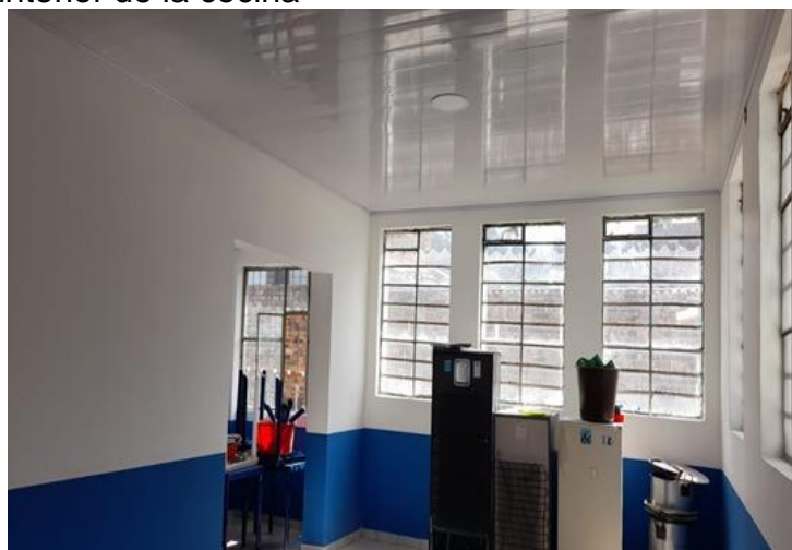
Figura 7. Vista interior de la cocina
