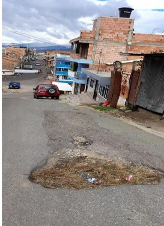
Figura 12. Fracturas presentadas en vías
