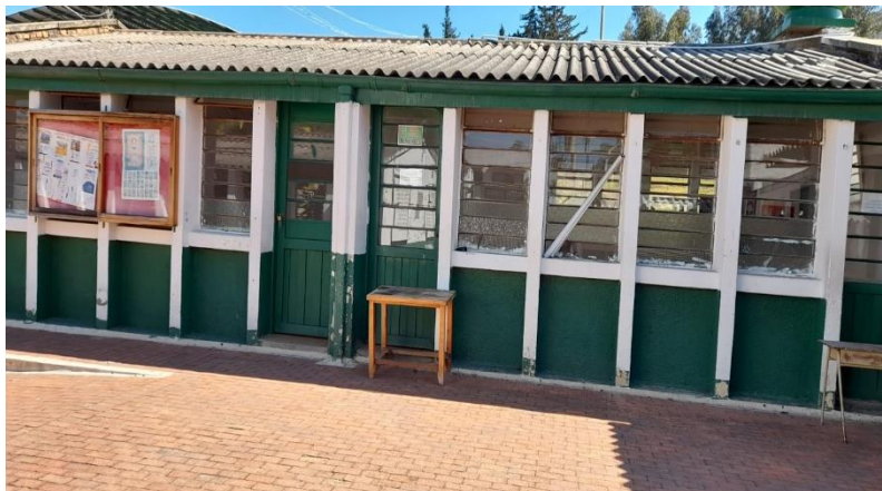
Figura 5. Vista exterior de la Institución.
