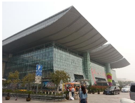
Figura 4. Puerta principal Distrito 4 del mercado
