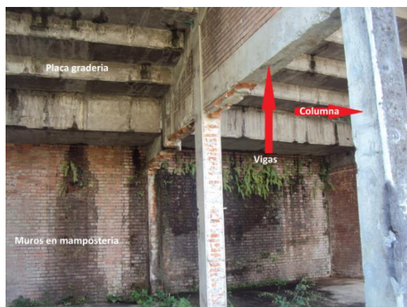
Figura 5. Sistema estructural pórticos y placa Fuente: Autor
