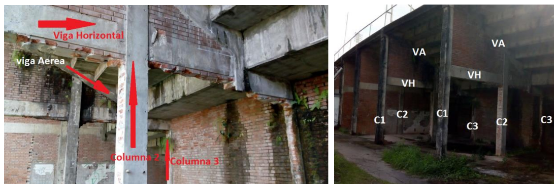
Figura 11. Vista pórticos Fuente: Autor
