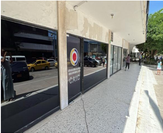
Imagen No. 1. Entrada edificio Gerencial Colegiada Departamental del Atlántico.
