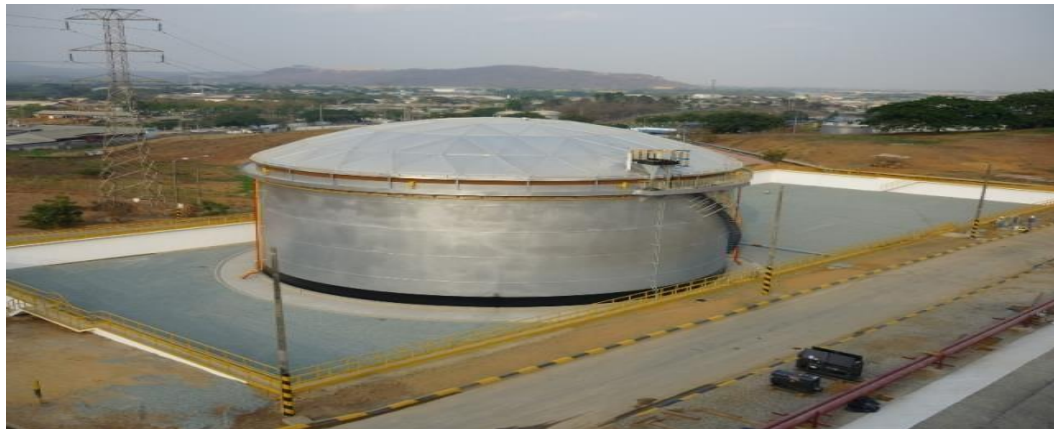
Figura 1. Tanque de almacenamiento con techo flotante
