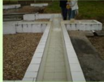
Cámara de Aquietamiento y Canal de Distribución
