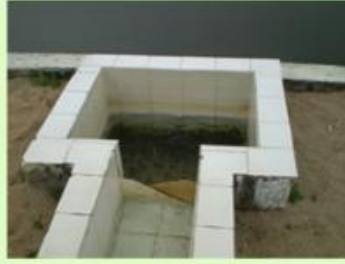
Caja Distribuidora Ascendente
