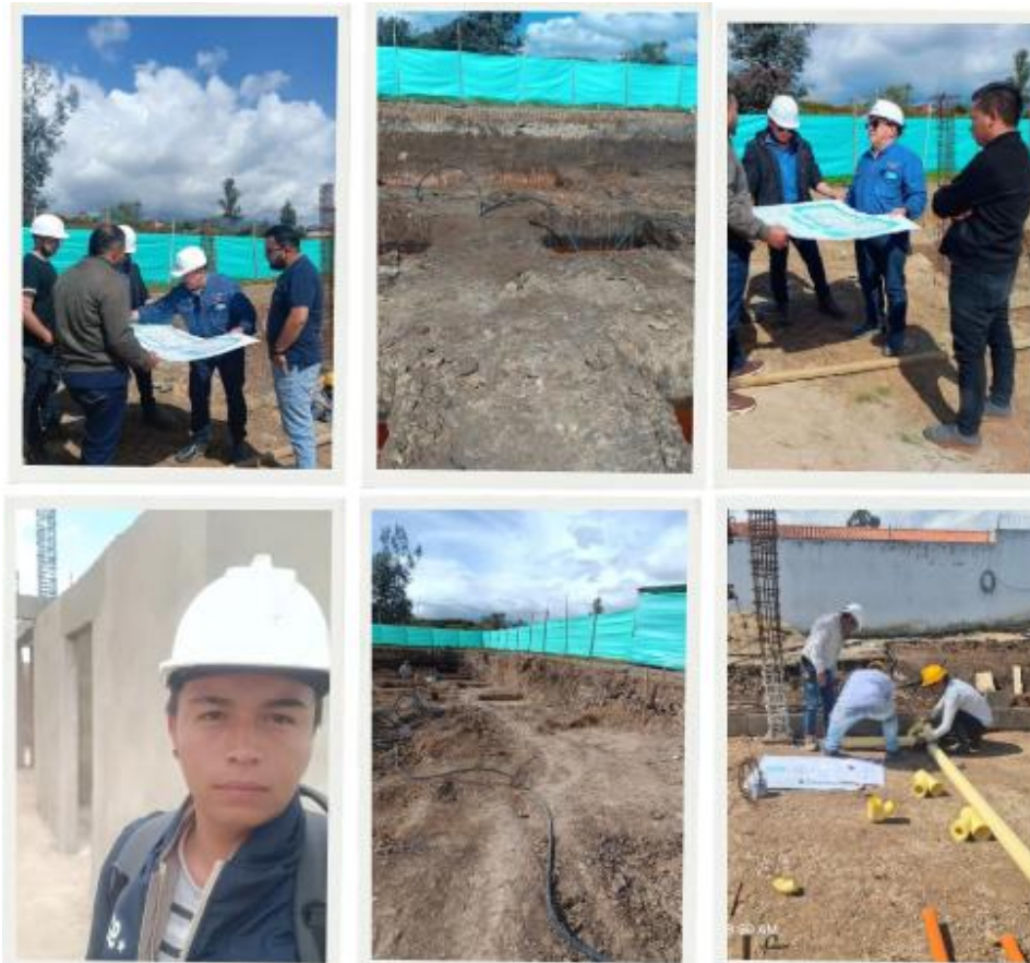
Ilustración 21. Visita técnica y supervisión de cimentación en el hogar geriátrico del municipio de Tuta, Dep. Boyacá.
