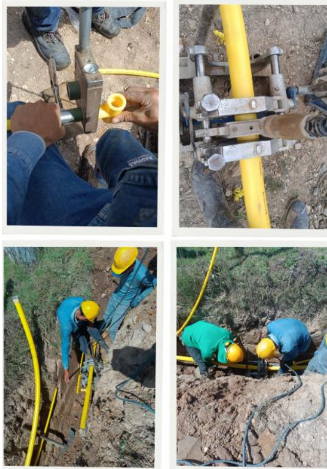
Ilustración 5. Verificación del proceso de termofusión a tope y socket en tubería PE de 2", 1/2" y 3/4" para res de gas Tibaná Dpto. Boyacá
