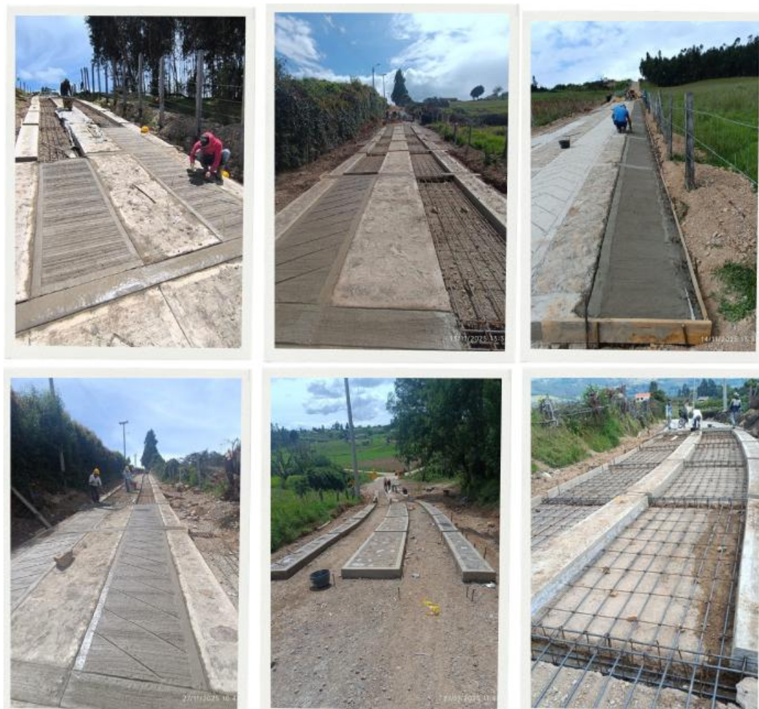
Ilustración 17. Visita técnica de seguimiento a la construcción de placa huella en el municipio de Sotaquirá., Dep. Boyacá.
