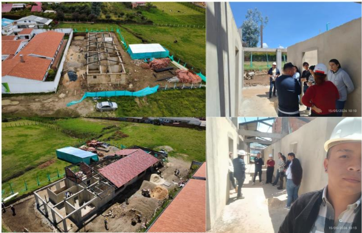
Ilustración 22. Seguimiento técnico de actividades constructivas del hogar geriátrico del municipio de Tuta., Dep. Boyacá.
