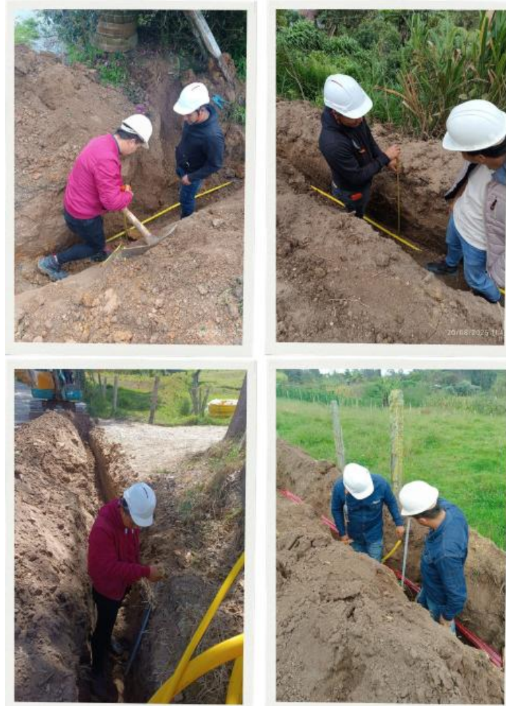
Ilustración 4. Visita técnica, verificación de excavaciones y dimensiones de zanja para la instalación de red de gas natural en el municipio de Tibaná Dpto. Boyacá
