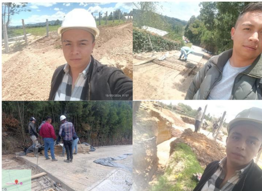
Ilustración 18. Supervisión técnica de actividades constructivas en placa huella, municipio de Sotaquirá., Dep. Boyacá.
