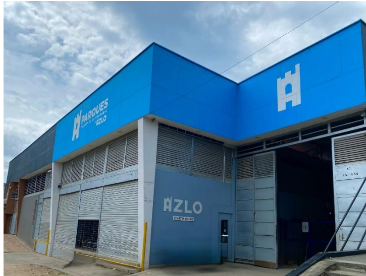
Figura 2. Fachada de la oficina principal GRUPO AZLO S.A.S. BIC
