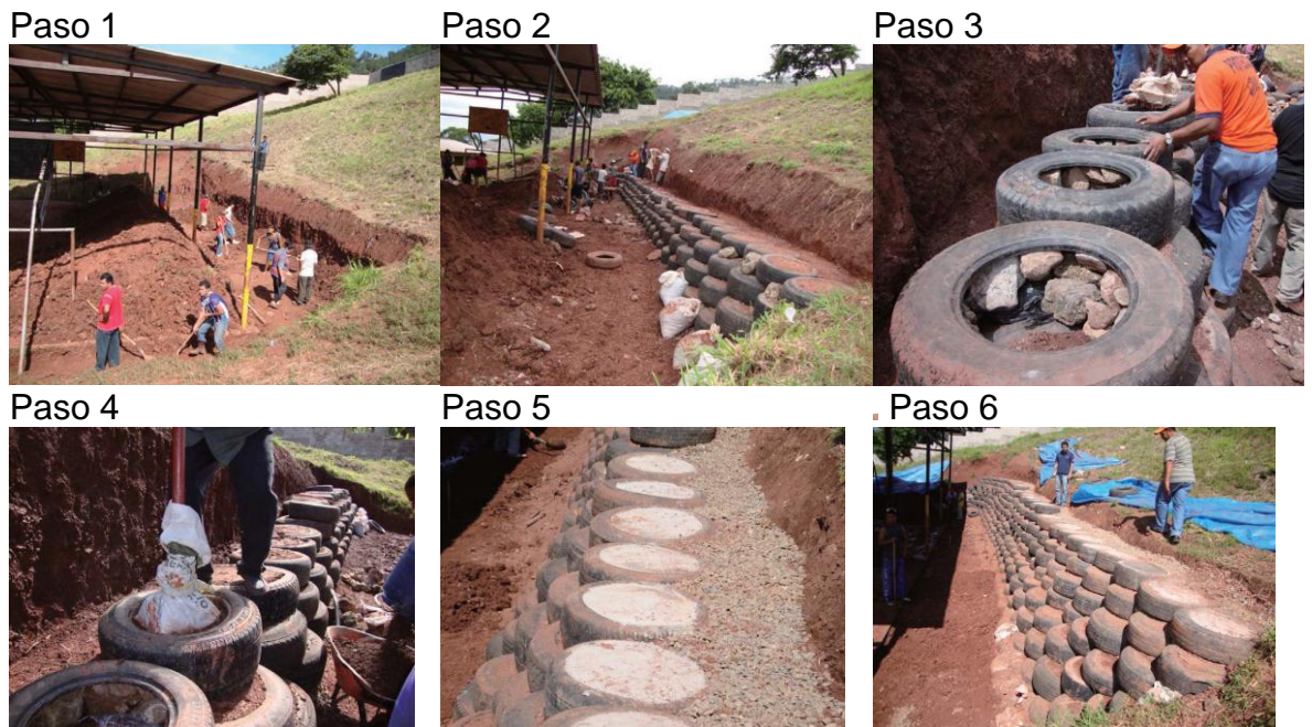
Figura 27 Proceso de constructivo de la Guía de la Construcción del muro de contención, con llantas usadas (Muro de Protección de Pendiente)
