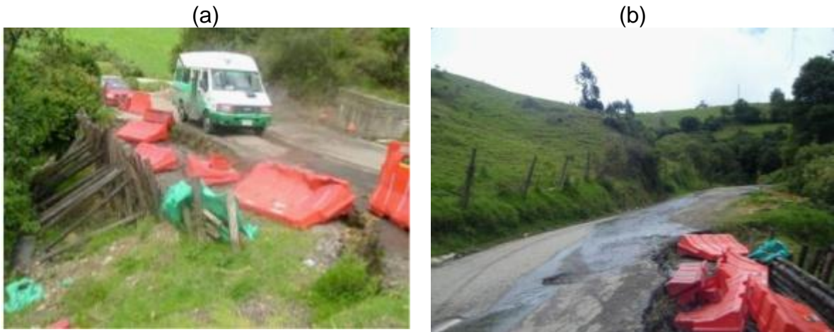
Figura 29 Zona de falla para construcción del muro
