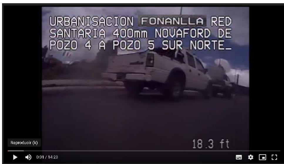
Ilustración 53. Video inspección con cámara Fonanlla pozo 4 a 5
