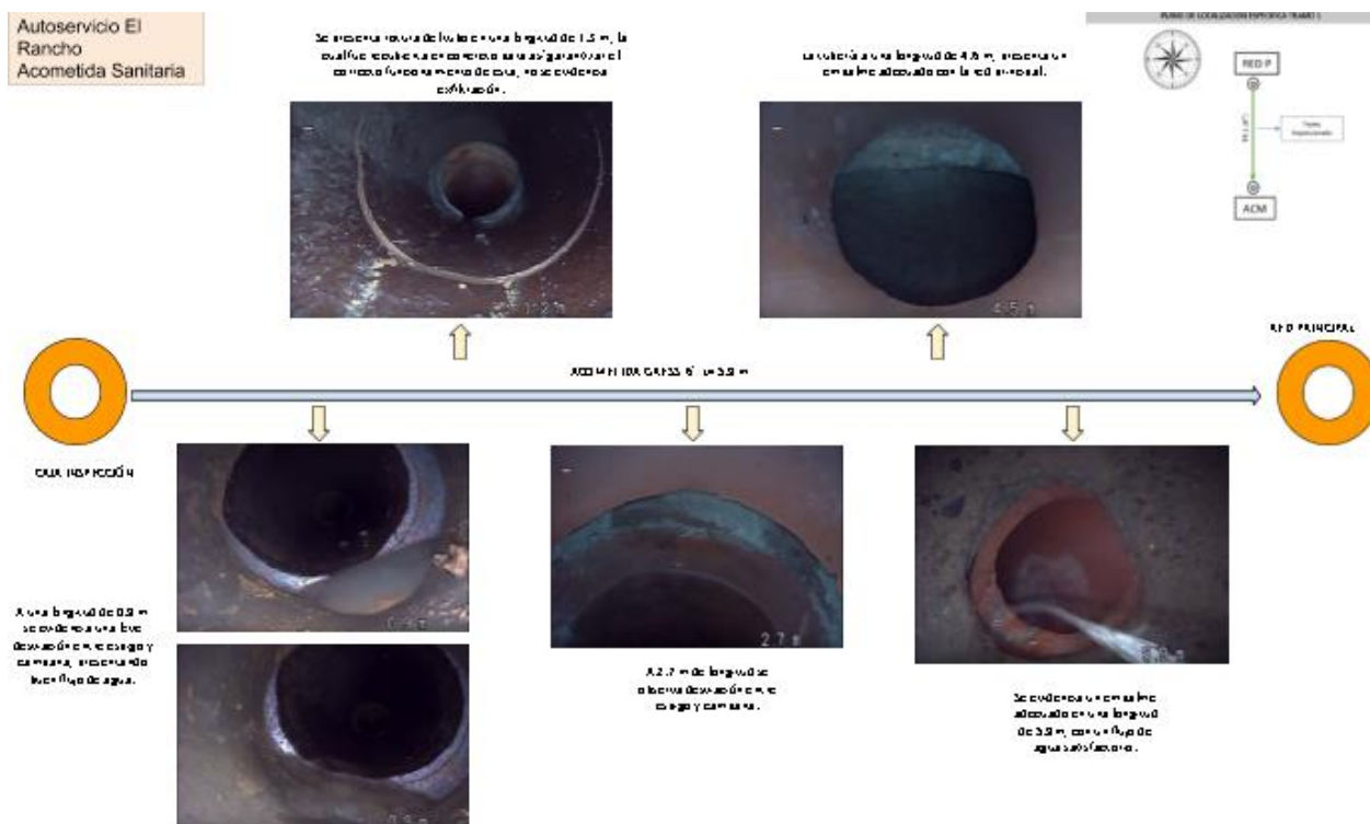
Ilustración 58. Informe inspección con cámara el Rancho pozo caja de inspección a red principal
