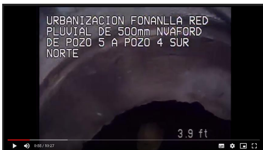
Ilustración 49. Video inspección con cámara Fonanlla pozo 5 a 4
