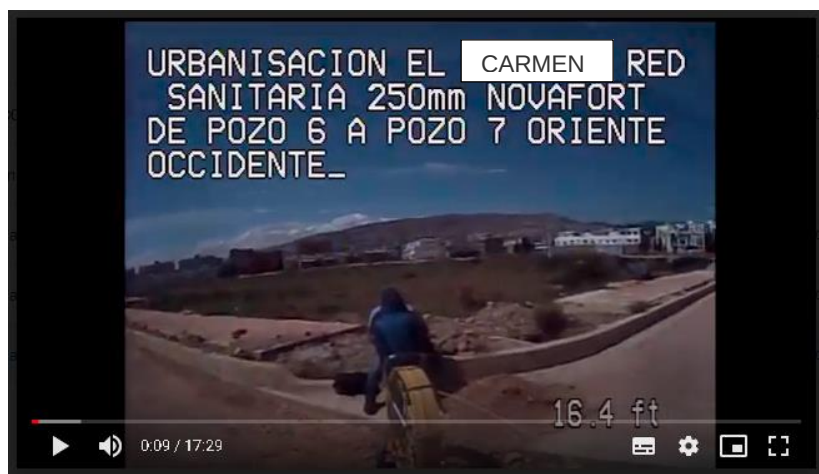
Ilustración 46. Video inspección con cámara el Carmen pozo 6 a 7
