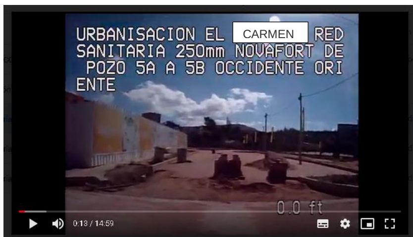
Ilustración 42. Video inspección con cámara el Carmen pozo 5A a 5B
