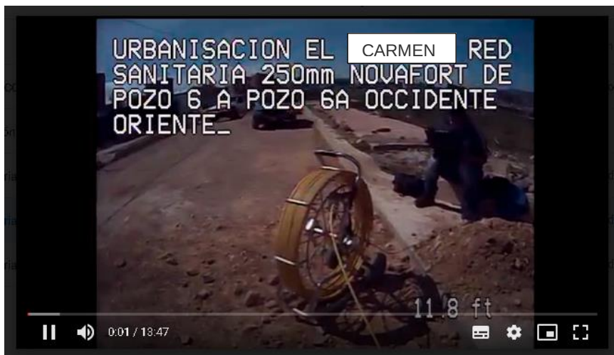
Ilustración 44. Video inspección con cámara el Carmen pozo 6 a 6A
