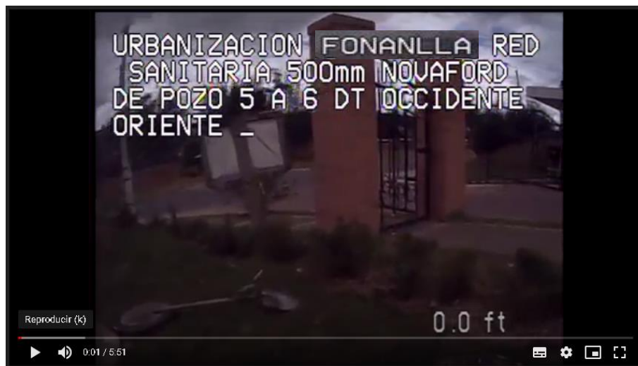
Ilustración 55. Video inspección con cámara Fonanlla pozo 5 a 6
