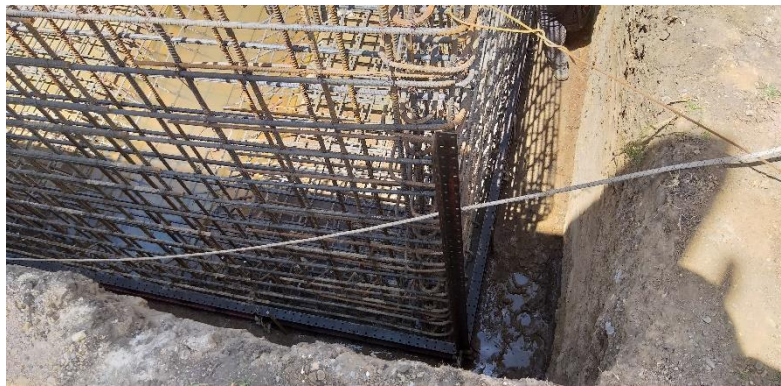
Figura 15. Armado de la formaleta para fundir concreto
