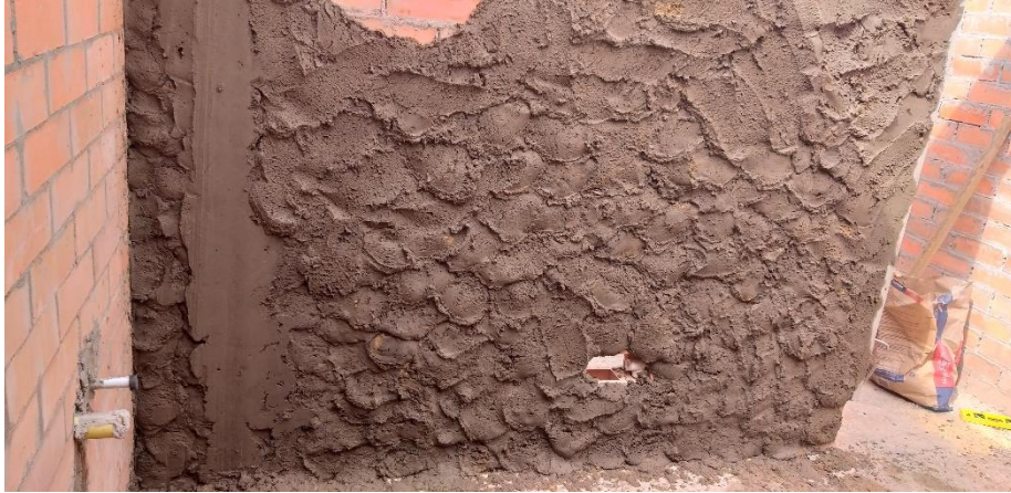
Figura 56. Pañete para muros de baños
