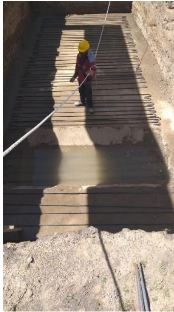
Figura 9. Armado del acero para Tanque de almacenamiento
