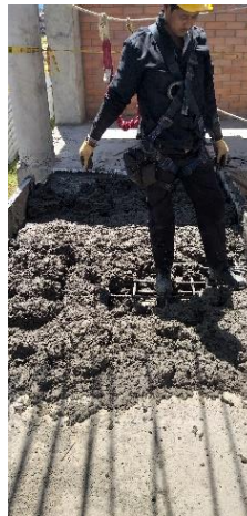
Figura 25. Vaciado de concreto para la primera placa de conexión entre bloque E y F
