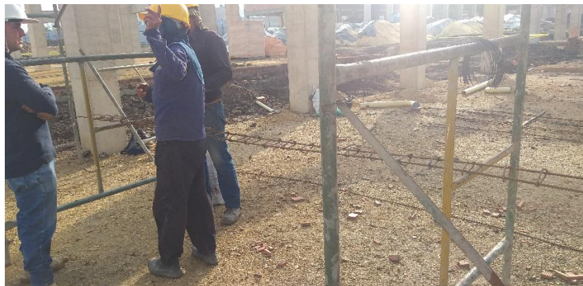
Figura 16. Amarre de canastas para viga cinta
