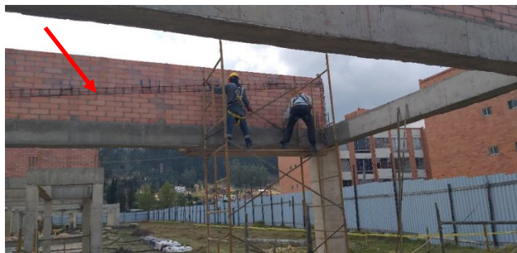
Figura 18. Instalación de canastas de acero sobre cuchillas
