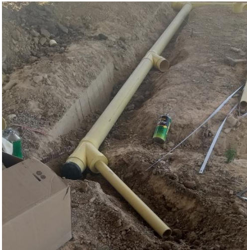
Figura 40. Instalación de tubería sanitaria para batería de baños
