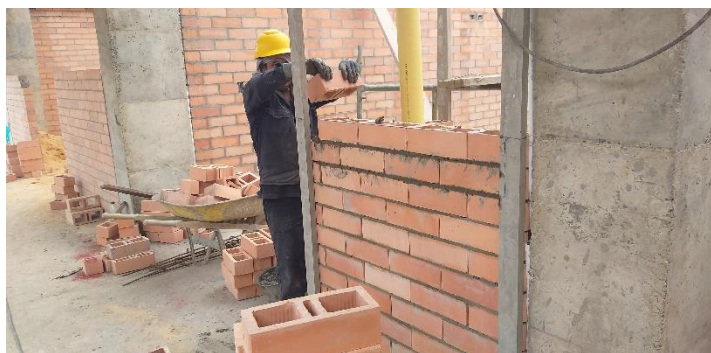
Figura 53. Construcción de muro de mampostería para recubrir las bajantes
