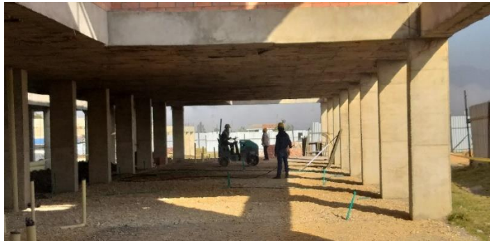
Figura 35. Adecuación de la zona para fundir placa
