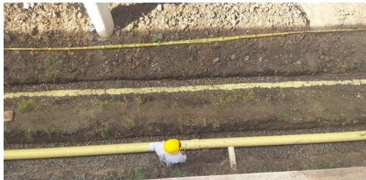
Figura 46. Instalación de tubería sanitaria para desagüe de agua lluvia y residual
