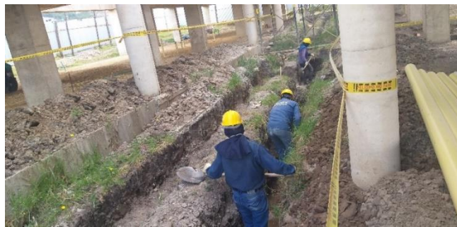
Figura 42. Excavación de zanjas para instalación de tubería
