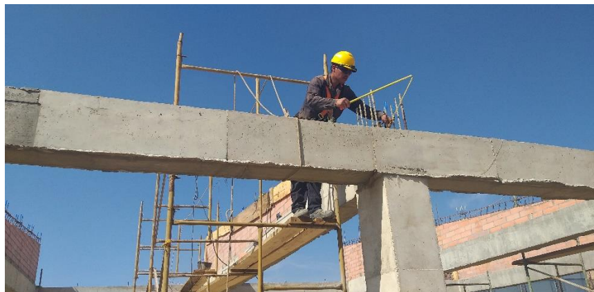
Figura 19.Verificación de medidas para fundir viga cinta
