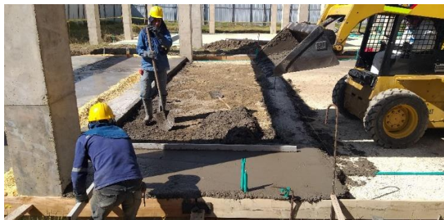
Figura 31. Vaciado del concreto por medio del mini cargador
