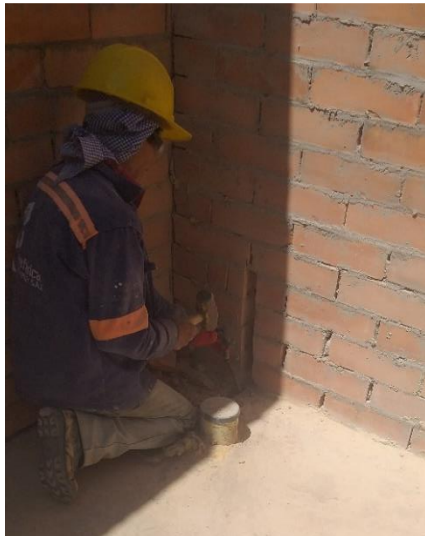
Figura 39. Excavación manual para instalación de tubería sanitaria
