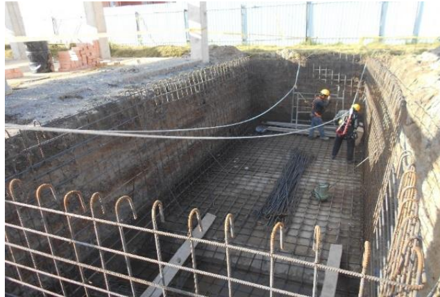
Figura 13. Amarre de aceros externos del tanque
