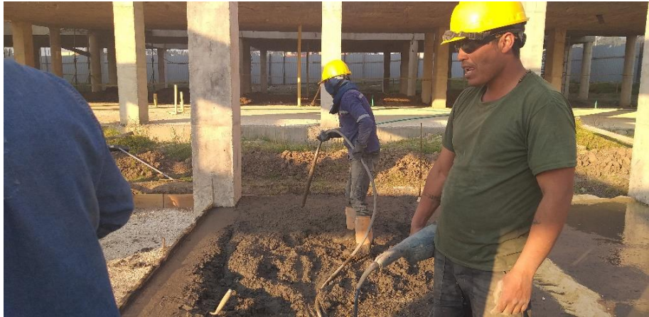
Figura 30. Vibración del concreto para liberación de la presencia de aire en la mezcla
