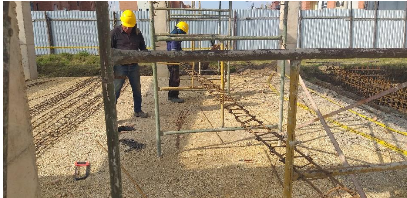
Figura 17. Figurado de canastas para viga cintas
