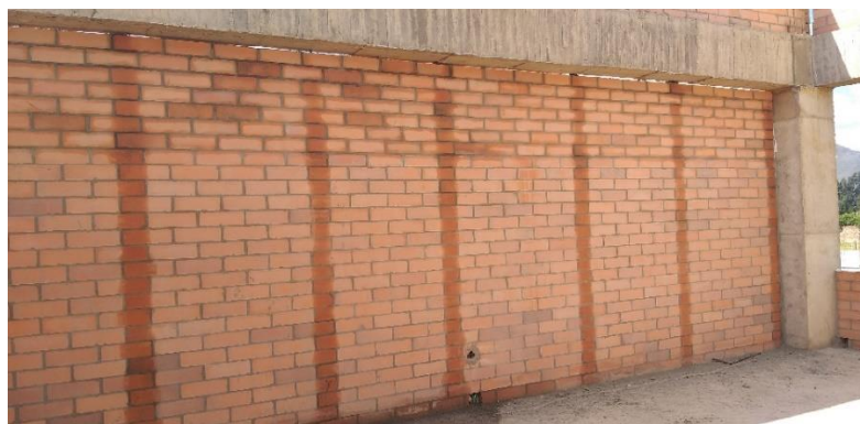
Figura 57. Instalación de dovelas para muros de mampostería
