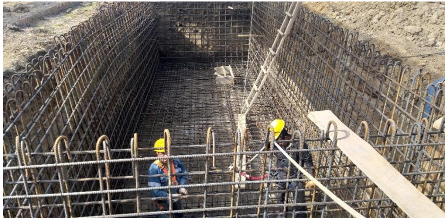
Figura 14. Armado de las dos canastas de refuerzo para tanque
