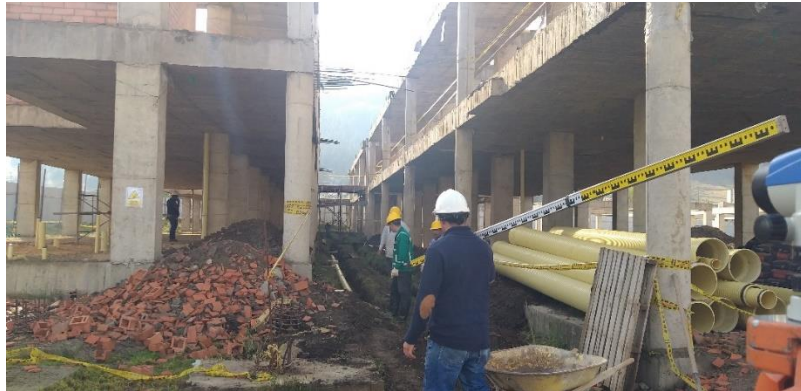
Figura 45.verificación de niveles y pendientes con nivel topográfico
