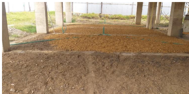
Figura 36. Aplicación de material fino para nivelar terreno
