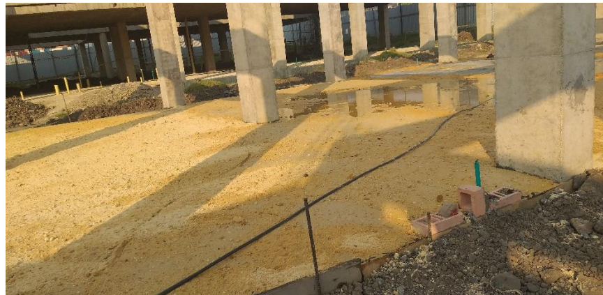
Figura 34. Curado de la placa terminada
