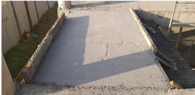
Figura 26. Terminado de la placa de conexión entre bloque E y F
