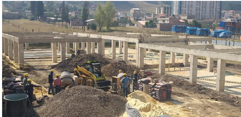
Figura 33.Zona de mezclado del concreto
