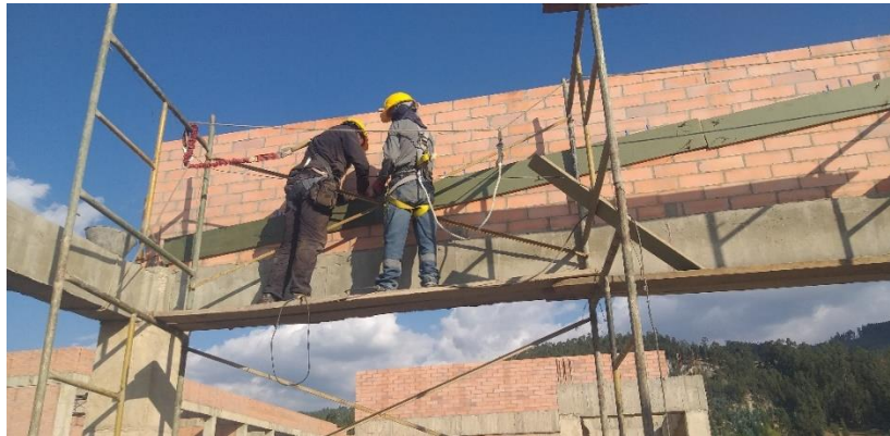
Figura 20. Instalación de formaletas para fundir viga cinta
