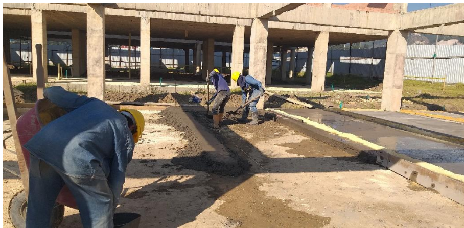
Figura 32. Alistado del terreno para fundir concreto
