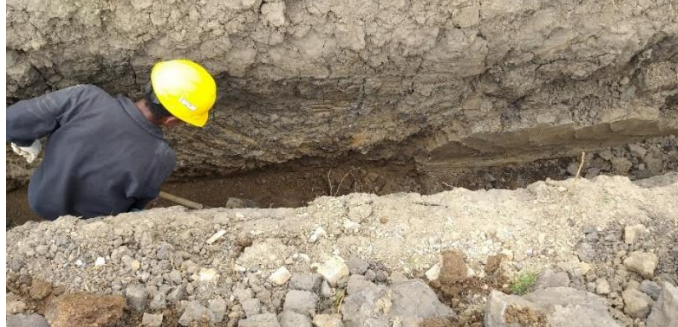
Figura 43. Excavación de zanjas para instalación de tubería de agua lluvia
