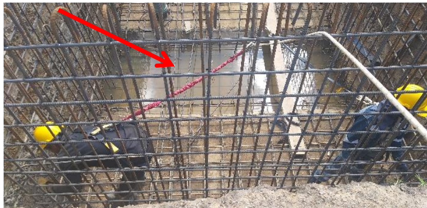
Figura 10. Amarre del Cárcamo del Tanque
