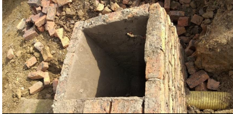
Figura 44. Construcción de cajas de inspección
