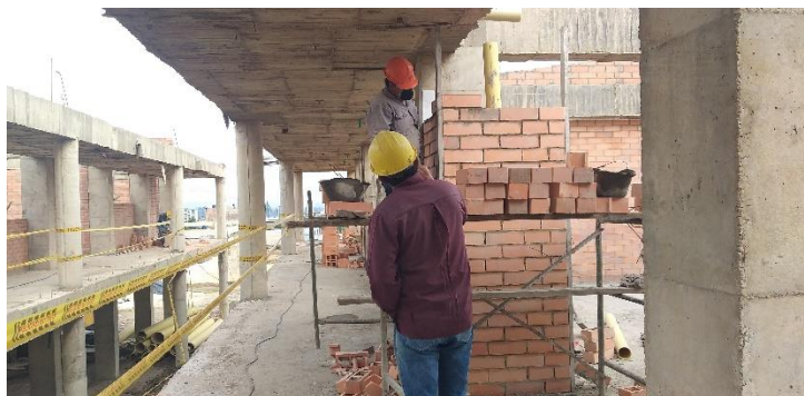
Figura 52. Construcción de muro de mampostería
