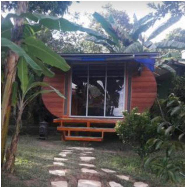
Ilustración 2 Montaje Industrias Metálicas Juven.
