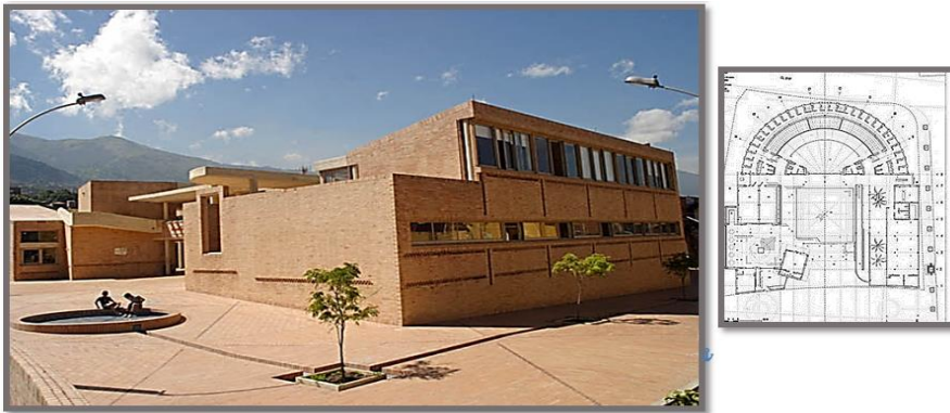
Figura 51. Vista desde el nor-este. Centro Cultural Moravia. Adaptado de archdaily. Año 2016
