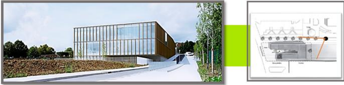
Figura 39. Vista Este Fachada posterior. Biblioteca Multimedia. Adaptado de archdaily. Año 2016
