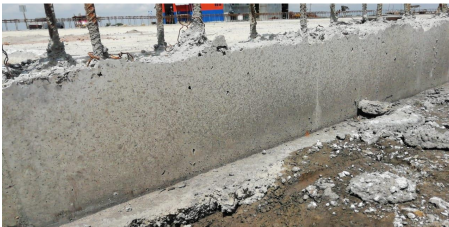
Figura 14 Desencofrado de concreto
