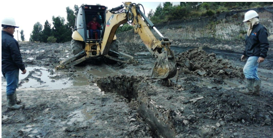
Figura 4 Excavación mecánica con retroexcavadora
