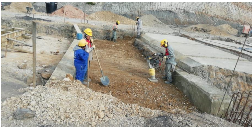
Figura 9 Compactación mecánica de recebo con canguro
