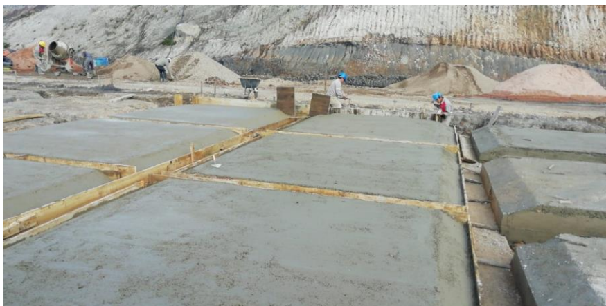
Figura 10 Estructuras fundidas en solado
