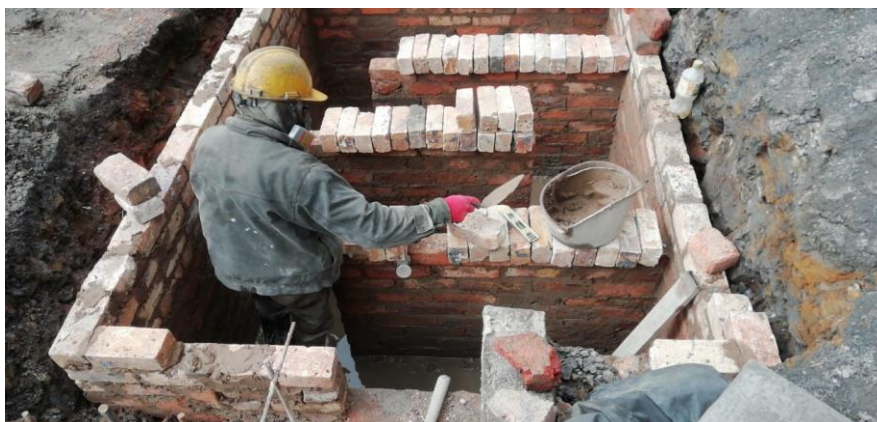
Figura 21 Proceso constructivo tanque sedimentador
