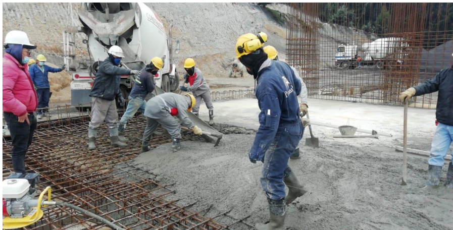
Figura 13 Vaciado de concreto
