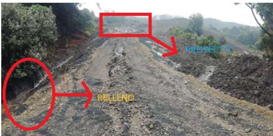
Figura 15 Vía de acceso BH2-Solera
