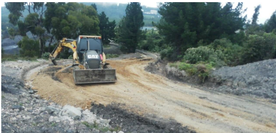
Figura 16 Mejoramiento vía de acceso BH2-Solera
