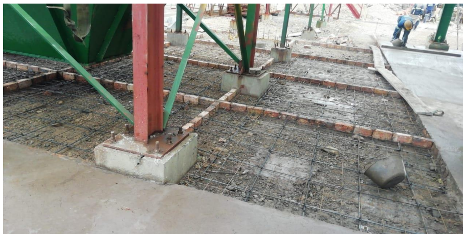
Figura 19 Refuerzo placa de concreto PLN
