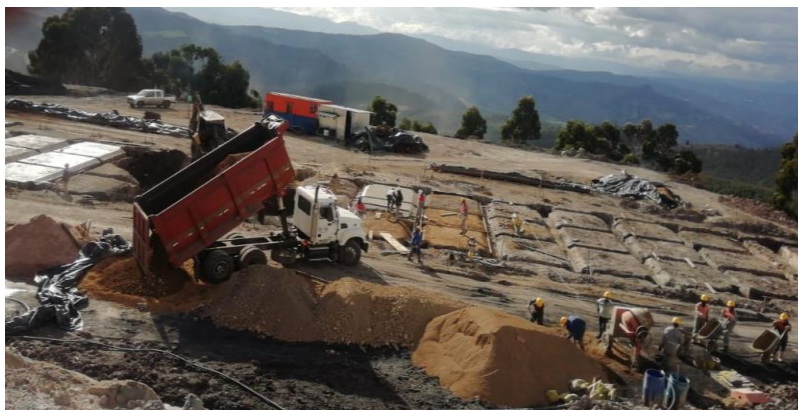
Figura 29 Batería Hornos 2 Solera
