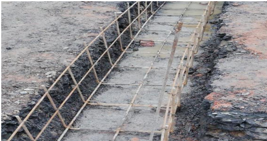
Figura 20 Refuerzo cuneta de concreto PLN
