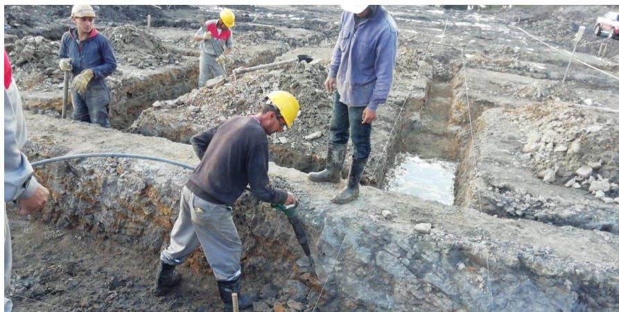
Figura 5 Excavación manual con martillo neumático
