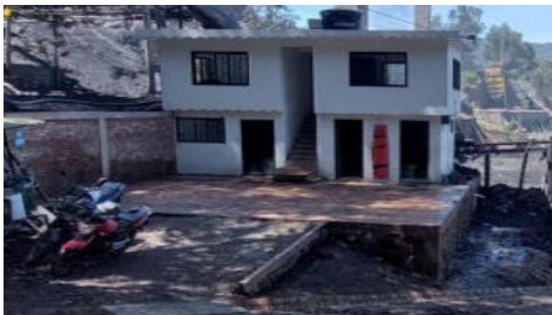
Figura 26 Cuarto de control bascula electrónica
