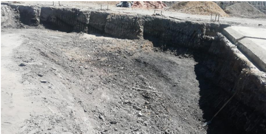
Figura 8 Zona de excavación manto de carbón
