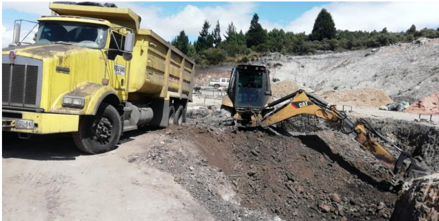
Figura 7 Excavación mecánica y retiro de material en volqueta
