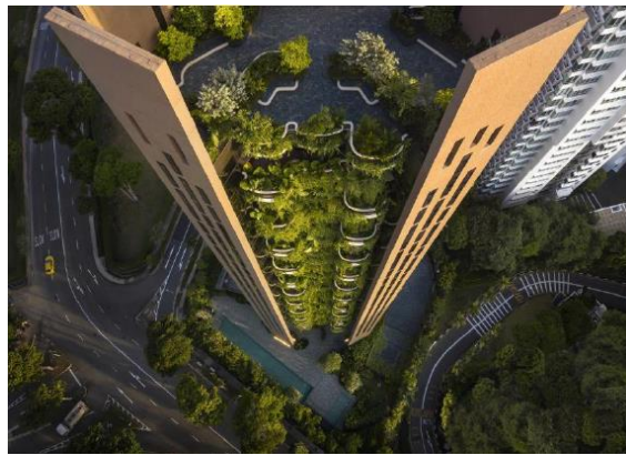
Figura 27. Fachada principal departamentos Edén
