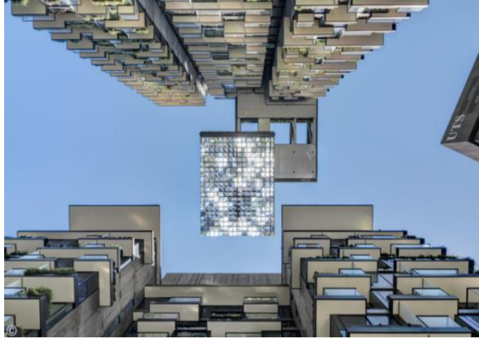
Figura 26. Voladizo y Heliostato
