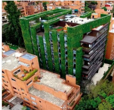
Figura 19. Edificio Santalaia -Jardin vertical en Bogotá
