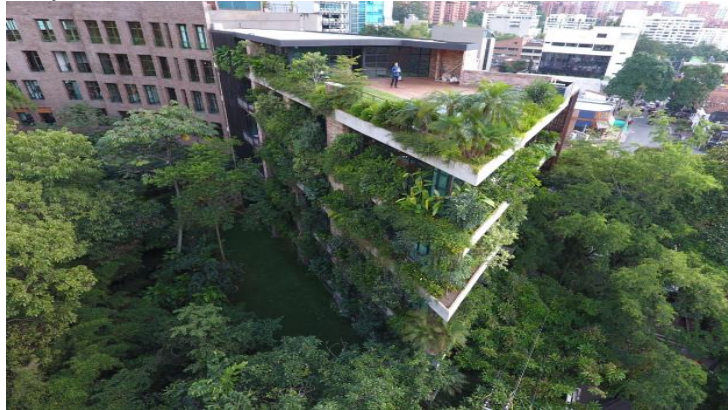
Figura 17. Fachada edificio El Matorral
