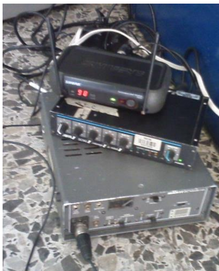
Figura 26. Instalación de RPT -15.
